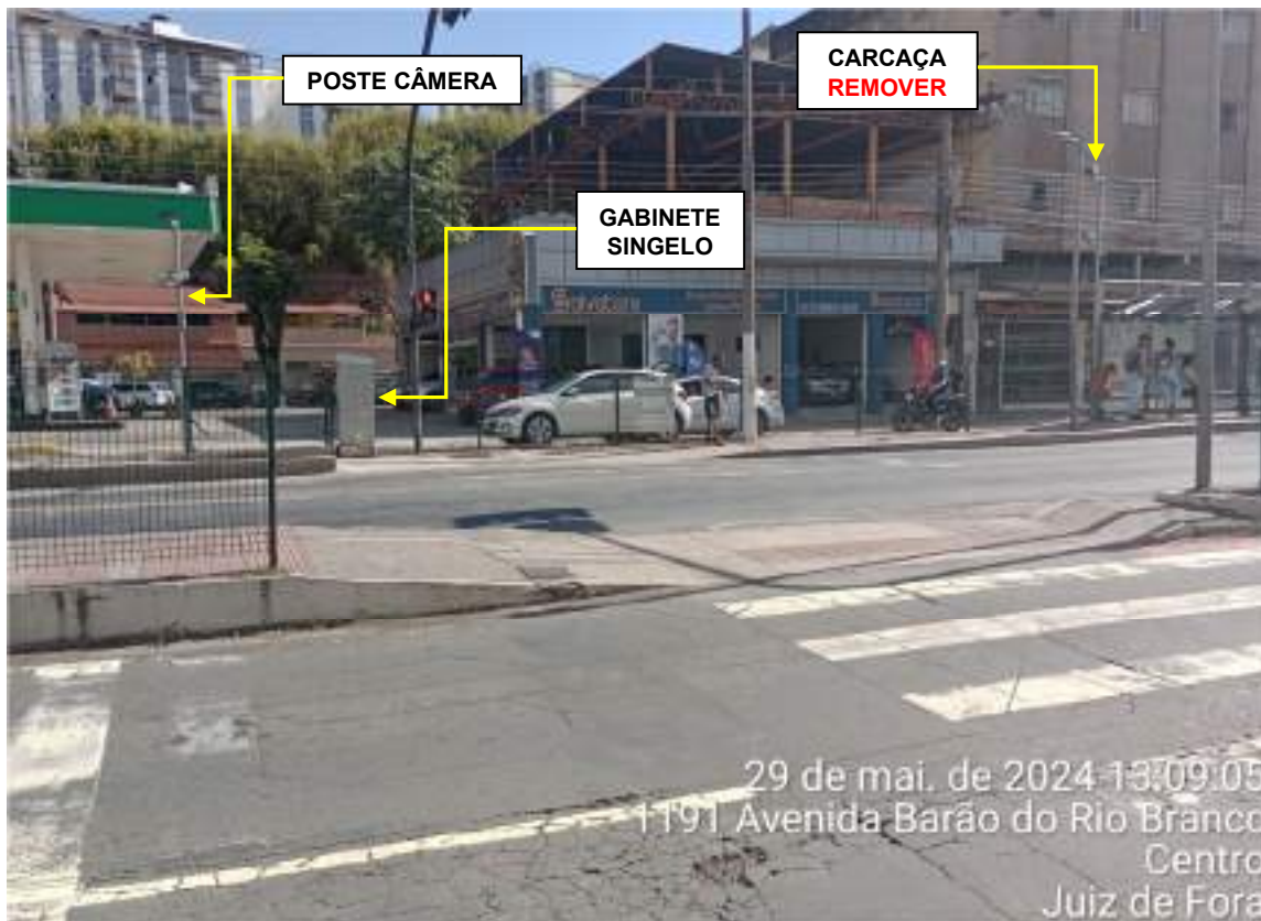
Foto 1: Av. Barão do Rio Branco, 1192 (Bairro / Centro).
