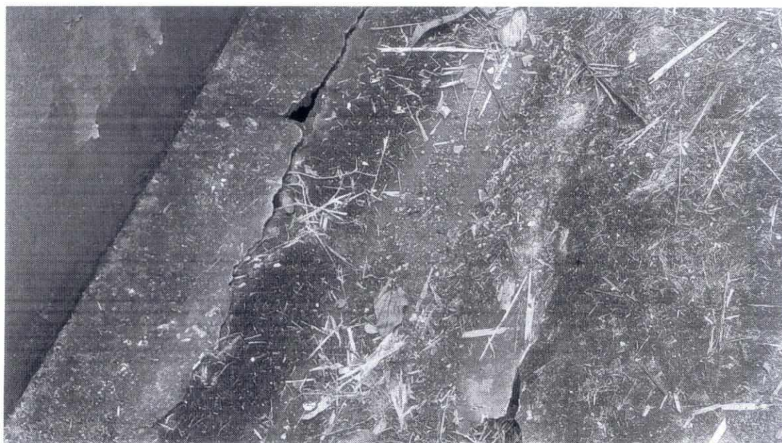
Figura 4 - Aberturas no piso, especificamente entre a base do muro de divisa e a canaleta situada ao seu pé.
