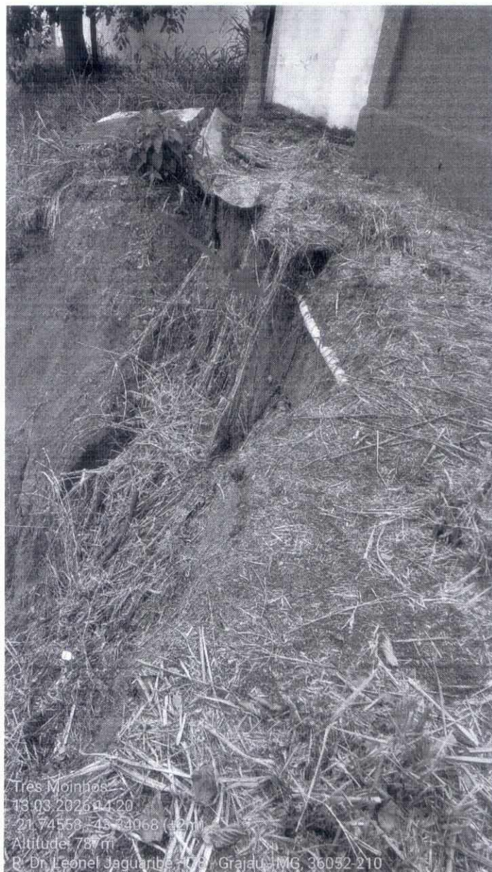
Figura 6 - Local do deslizamento de solo e trecho da rede de esgoto rompida e tensionada.
