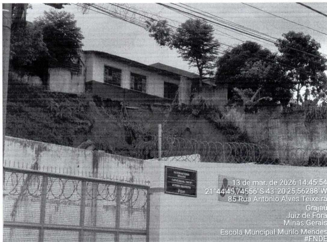
Figura 9 - Vista de baixo, próximo ao ponto de acesso ao lote onde se situa o reservatório Grajaú pertencente à CESAMA.
