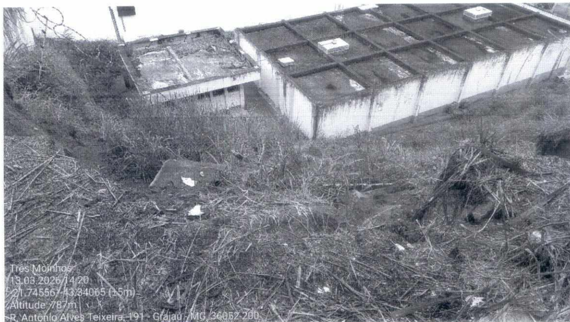
Figura 8 - Vista superior da Adutora situada nas proximidades da Escola e frontal ao do ponto do deslizamento de solo ocorrido em decorrência das intensas chuvas que acometeram o município de Juiz de Fora no dia 23 de fevereiro de 2026.
