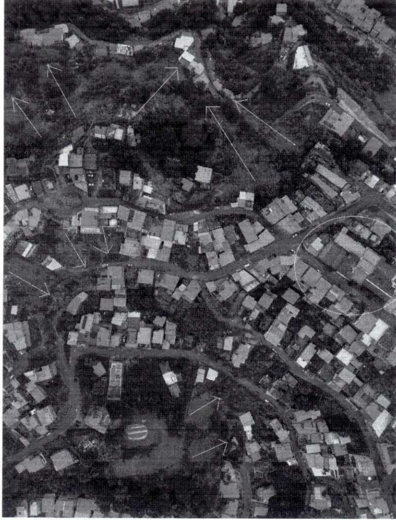
Figura 11 - Imagem apresentando a localização da escola (circulada), bem como múltiplos escorregamentos de talude no entorno da instituição de ensino, assim como junto da escola.
