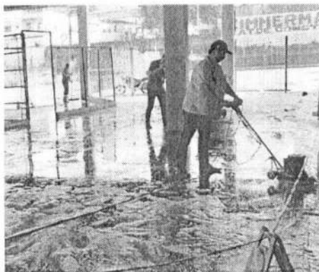
Figura 27 Limpeza e tratamento do piso
