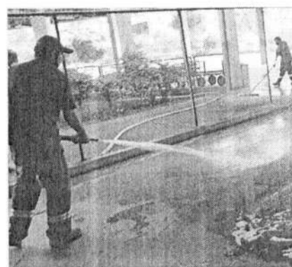
Figura 28 Limpeza e tratamento do piso
