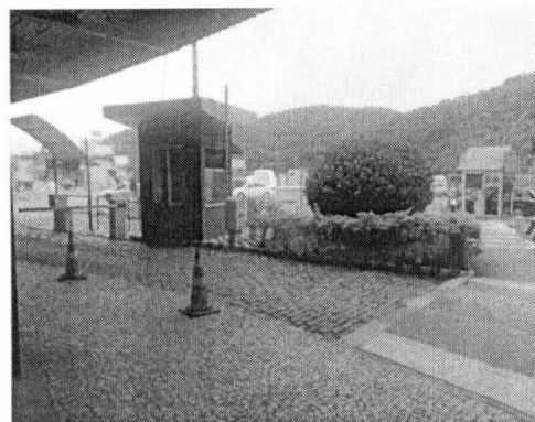
Figura 14 Catraca de Saída do Estacionamento
