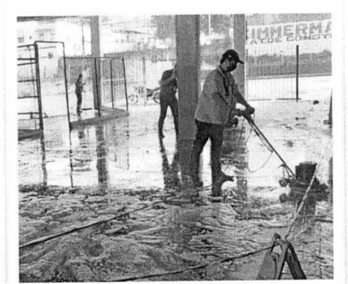
Figura 27 Limpeza e tratamento do piso
