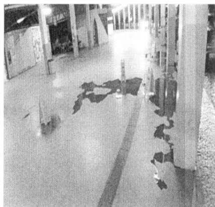
Figura 27 Pontos de Goteira
