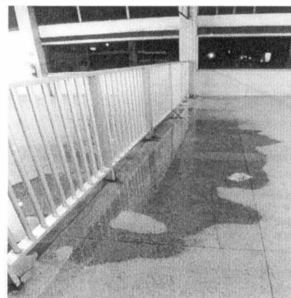
Figura 28 Pontos de Goteira
