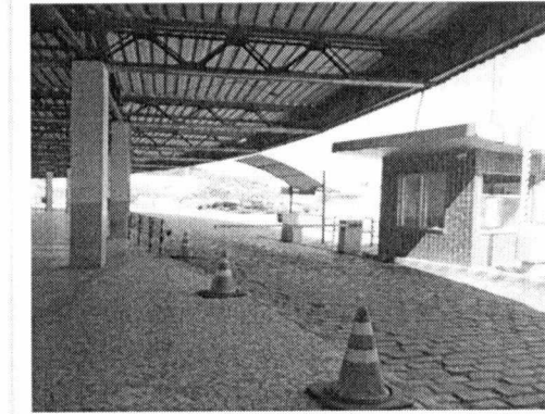
Figura 14 Catraca de Saída do Estacionamento
