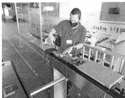
Figura 15 Controle de Acesso
