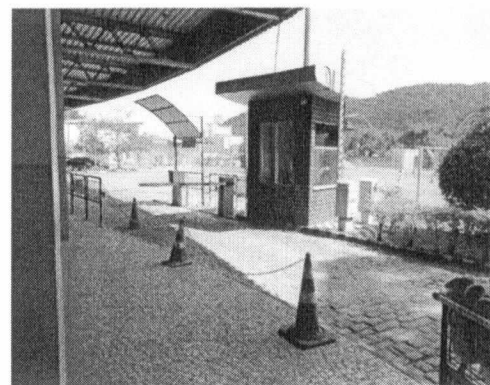
Figura 14 Catraca de Saída do Estacionamento
