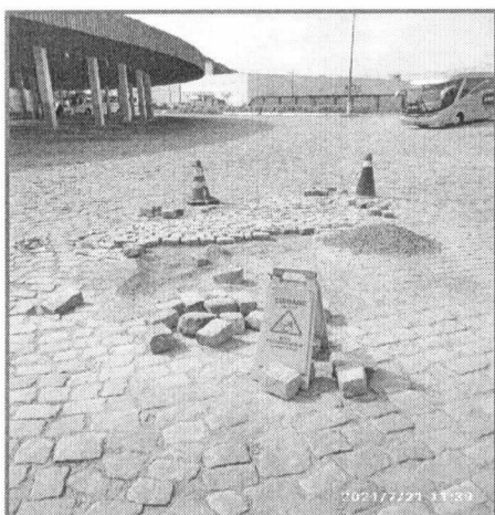
Figura 16 Pavimento em Obra
