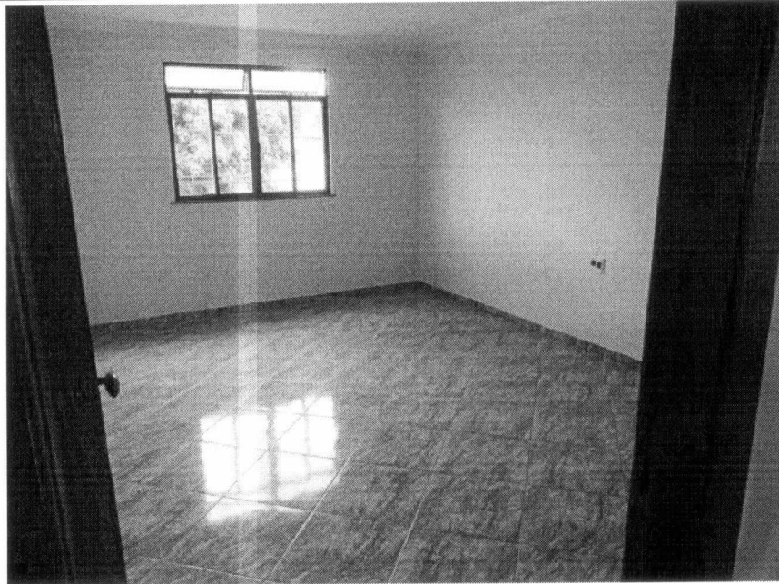
Imagem 05: Imóvel avaliando – Área interna 2º pavimento (Fonte: Fotografado pelo Autor).
