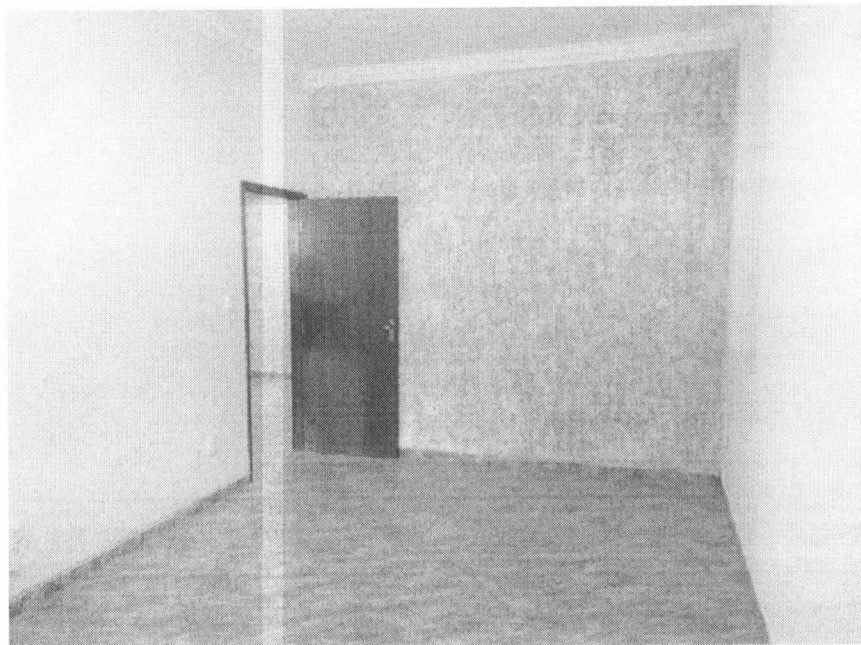
Imagem 10: Imóvel avaliando – Área interna 1º pavimento (Fonte: Fotografado pelo Autor).
