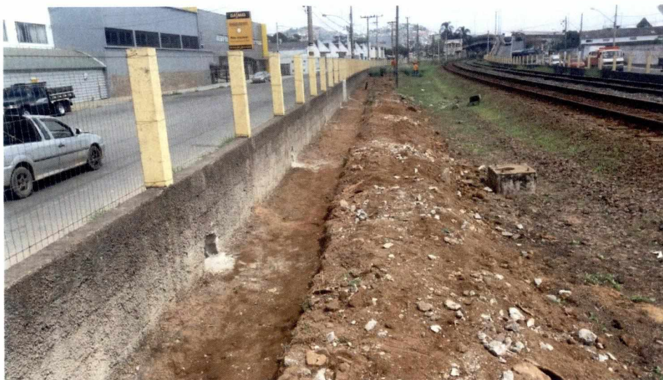
Abertura de vãos e retirada de material sólido depositado rente ao muro
