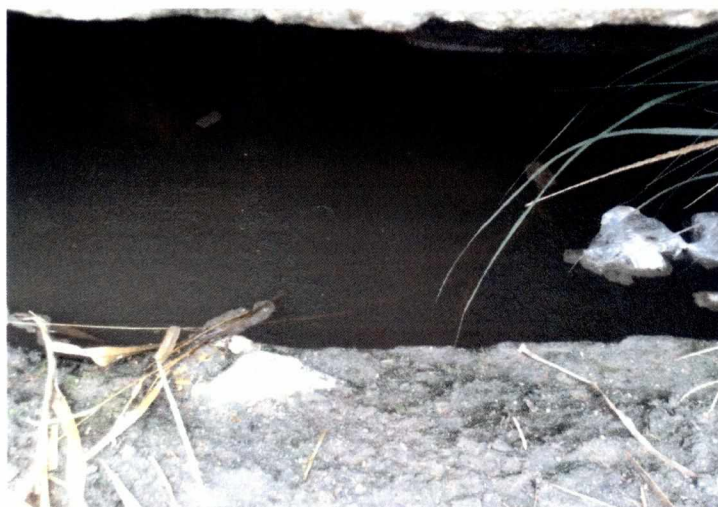
Detalhe interno da boca de lobo existente no local do afogamento da tubulação
