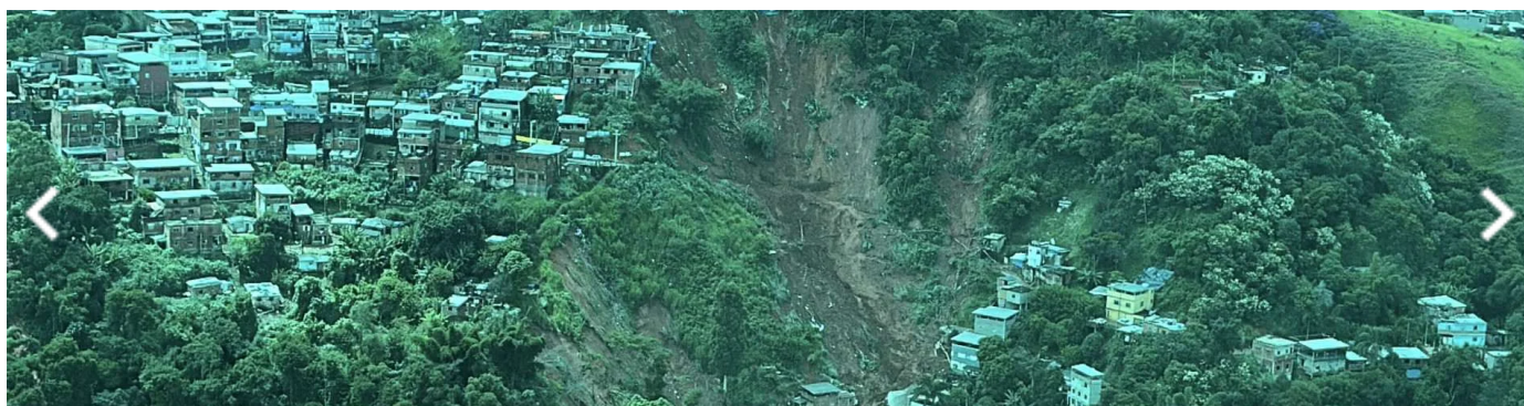
Deslizamentos, alagamentos e estragos nas estruturas da cidade foram registrados após fortes chuvas Governo de Minas/Divulgação
