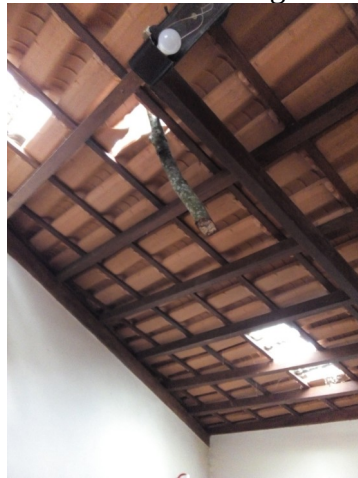
Como o galho penetrou no telhado
