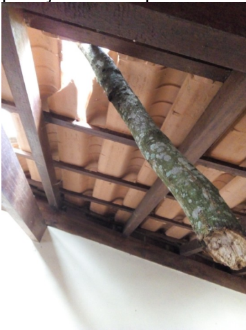
Como o galho penetrou no telhado
