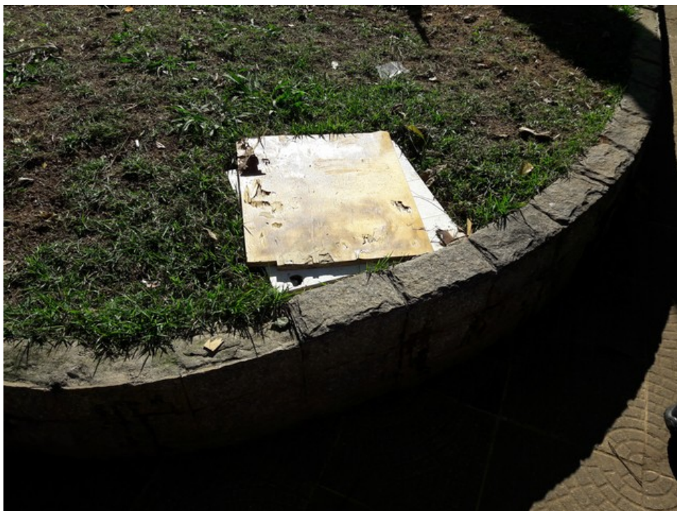
Caixa de passagem hidráulica
