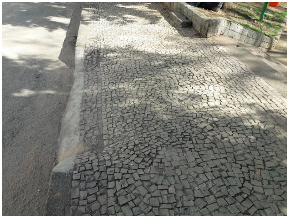
Rampa de acesso à praça
