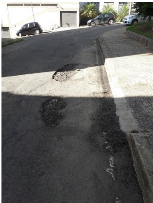
Rampa de acesso à praça
