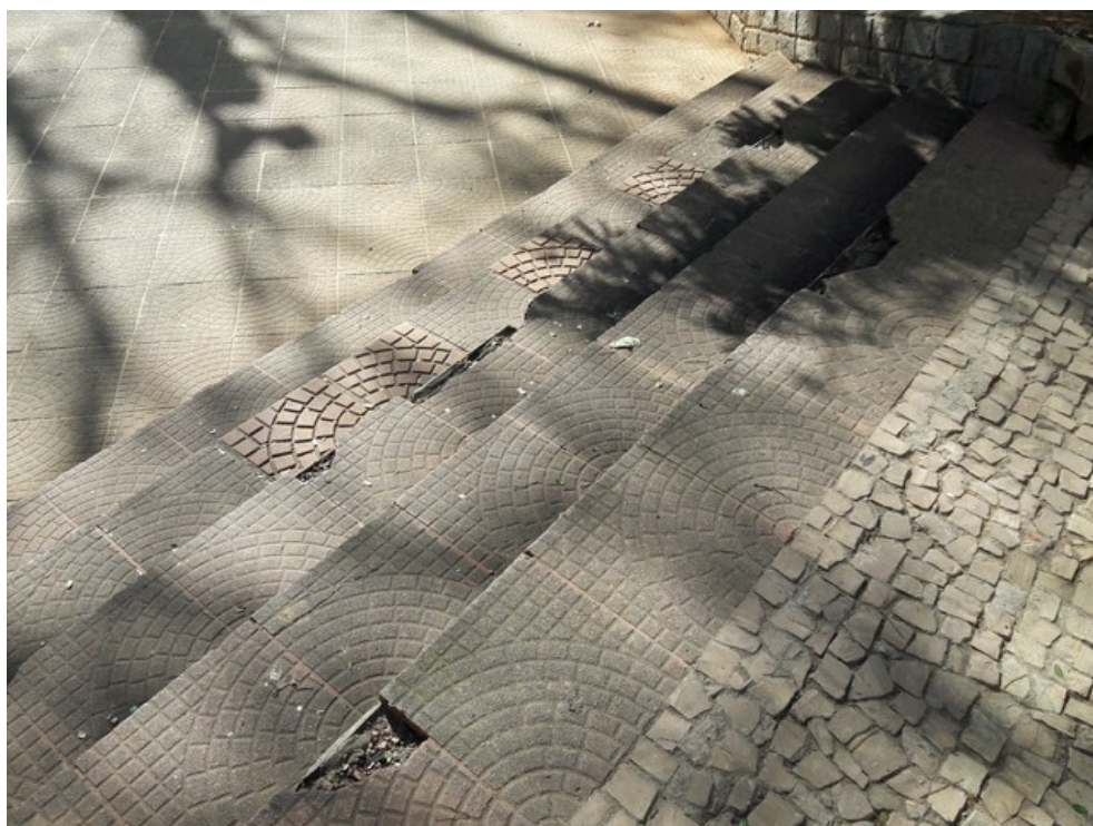
Escada para acesso ao centro da praça
