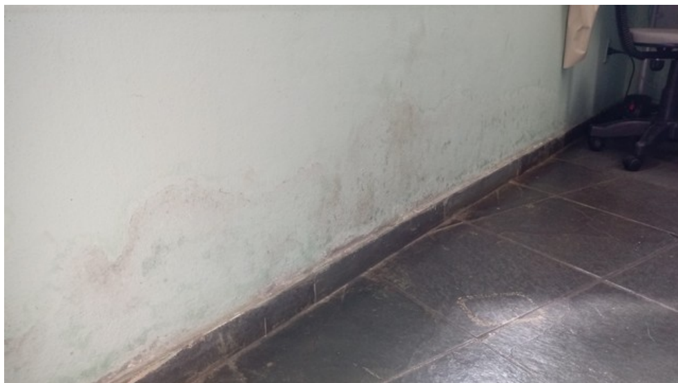
Parede da sala da diretoria e coordenação pedagógica
