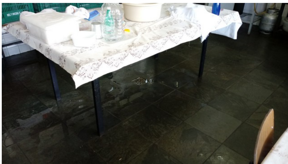
Chão da cozinha
