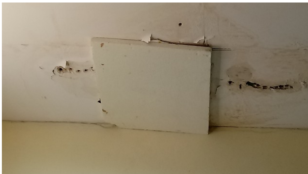
Teto do segundo andar
