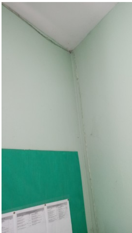
Parede da sala da diretoria e coordenação pedagógica
