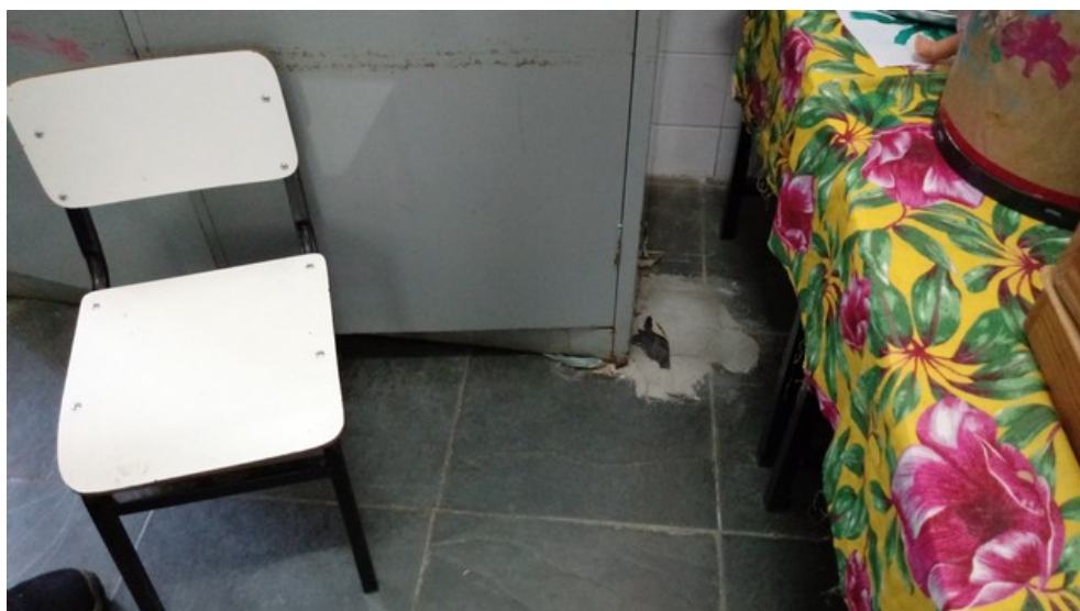
Chão da sala de aula
