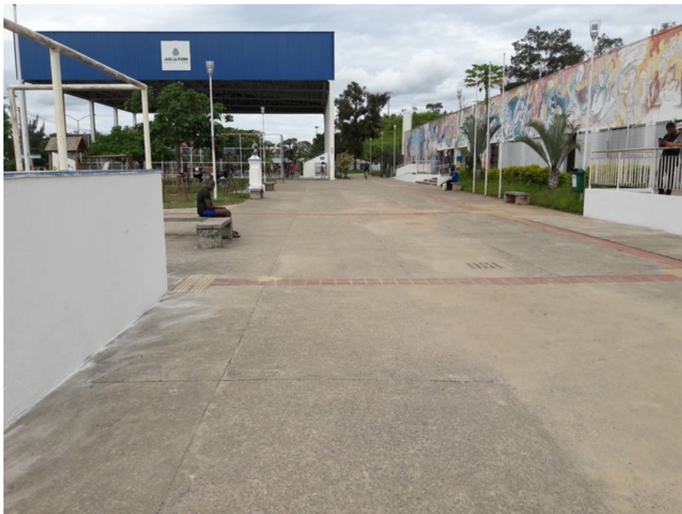
Vista geral da praça
