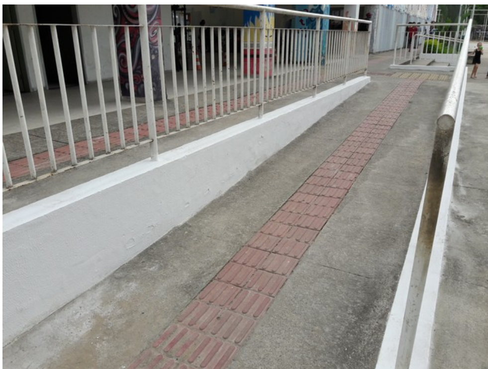
Rampa de acesso às salas de aula, cine teatro e administração
