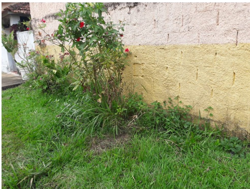
Parte do muro do pátio (lado de fora da escola)
