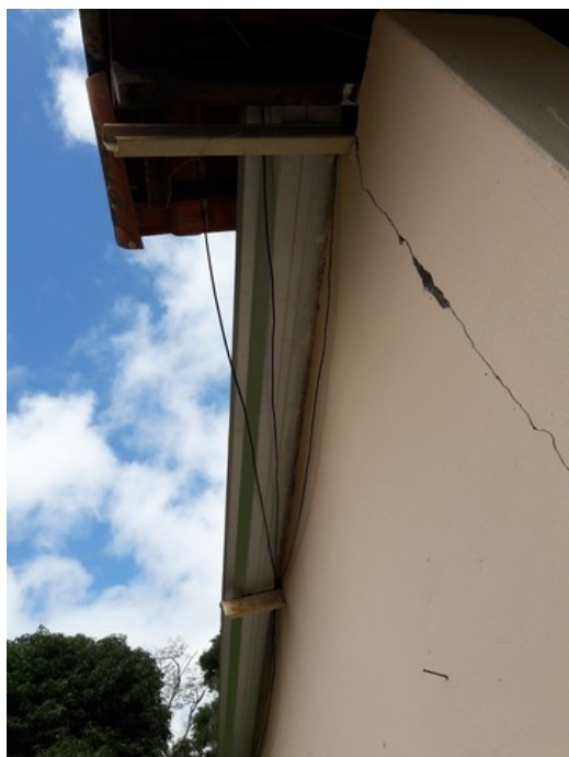
Parede e estrutura elétrica ao lado do pátio
