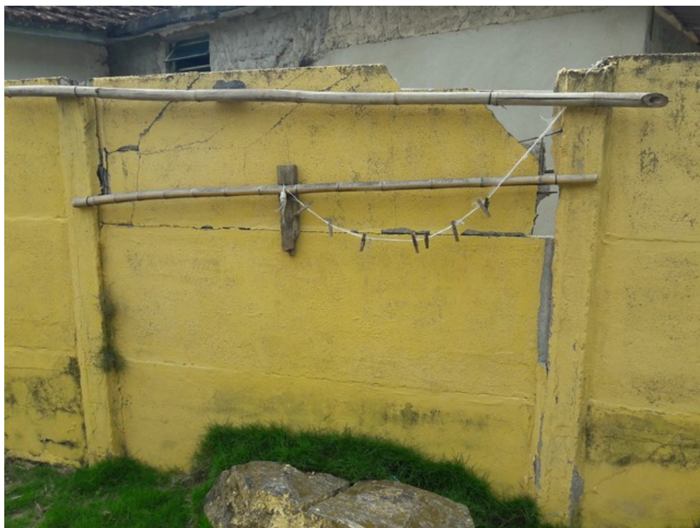
Parte do muro do pátio
