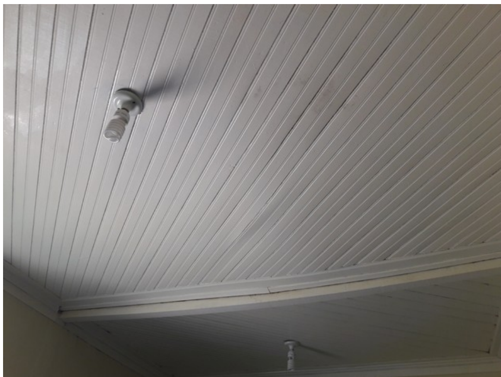
Forro da sala de leitura
