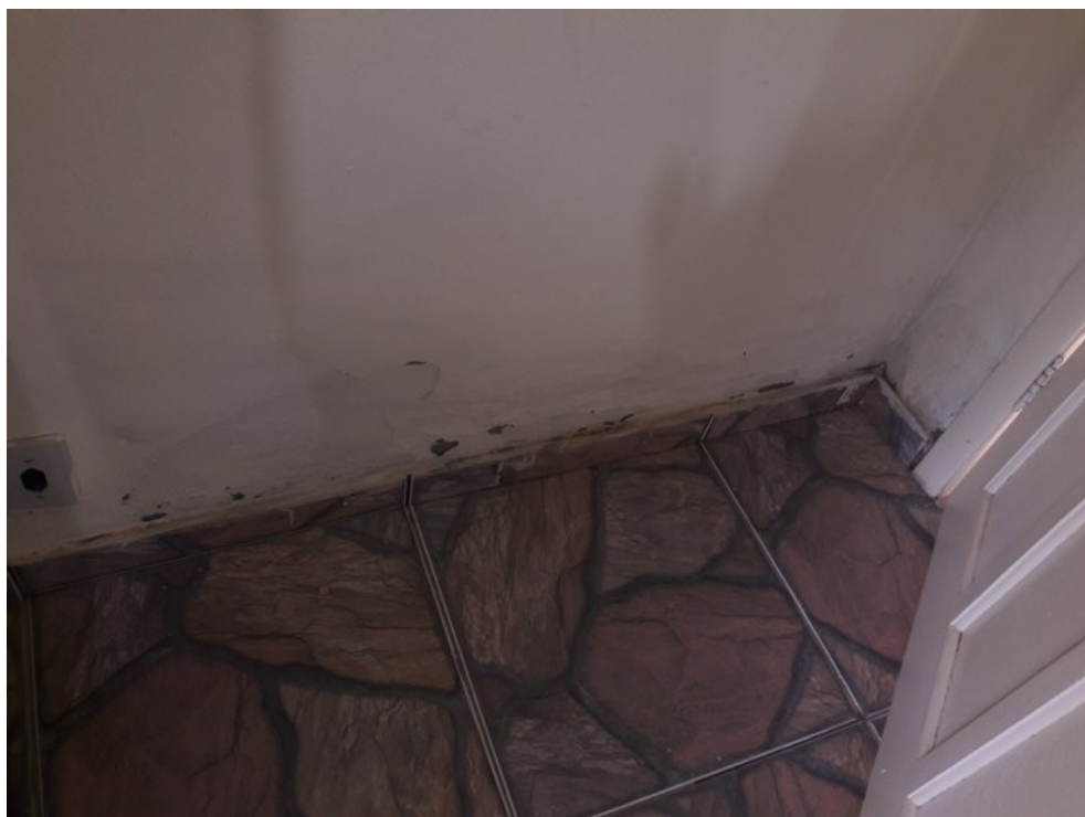
Parede e piso da sala de aula
