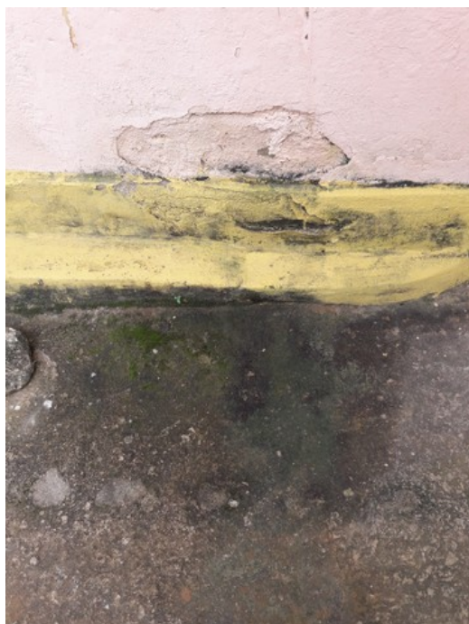
Parte externa da parede do banheiro dos professores
