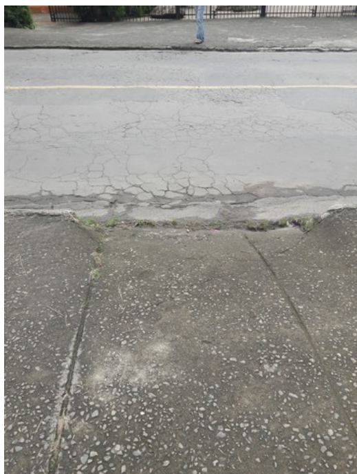
Rampa de acesso à praça
