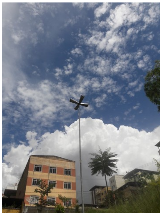
Poste de iluminação
