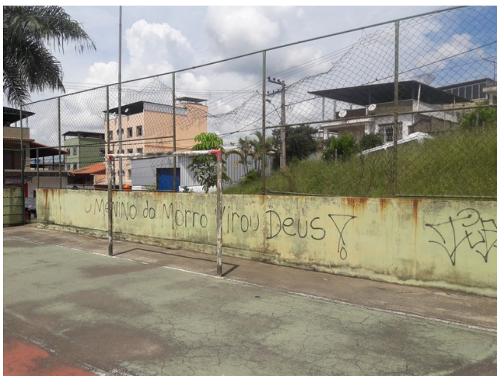
Traves e alambrado da quadra
