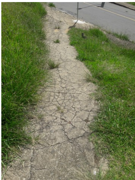
Rampa de acesso à praça
