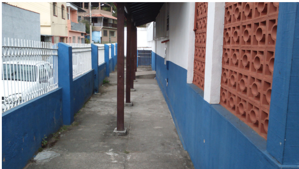
Corredor de acesso lateral da unidade
