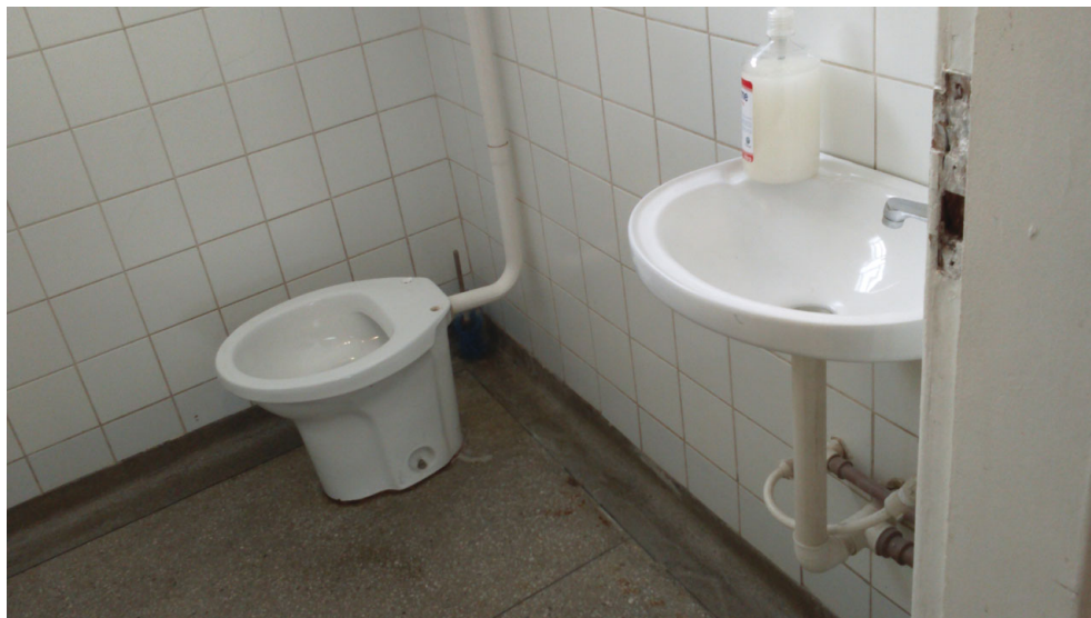
Banheiro Unisex dos funcionários
