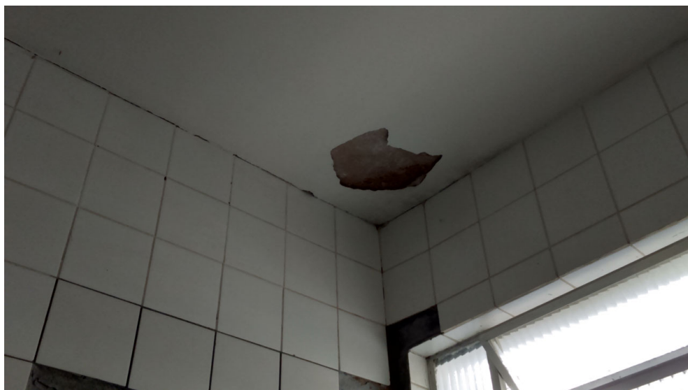
Banheiro Unissex dos funcionários
