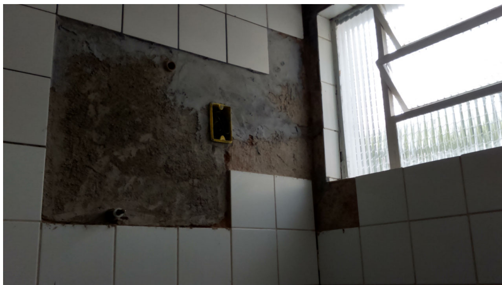
Banheiro Unisex dos funcionários
