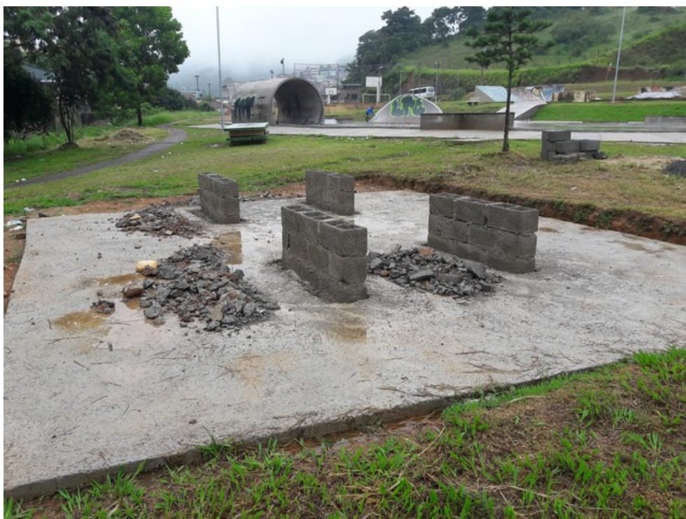
Área em obra
