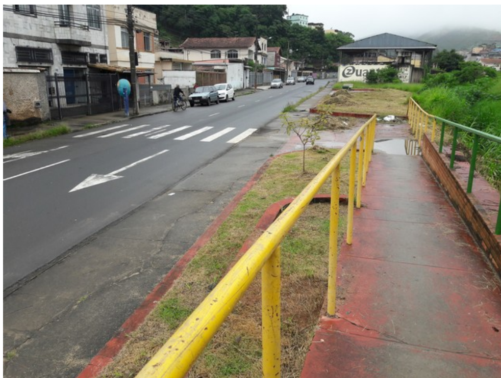
Rampa de acesso à praça, com corrimão e faixa de pedestres
