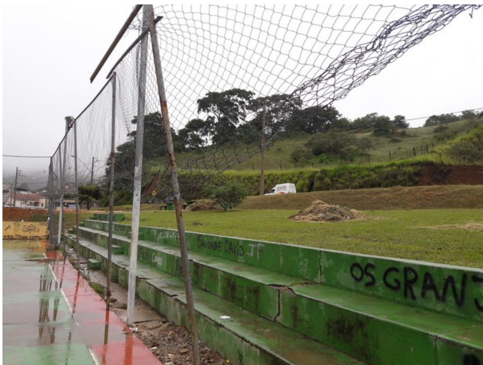
Alambrado da quadra poliesportiva
