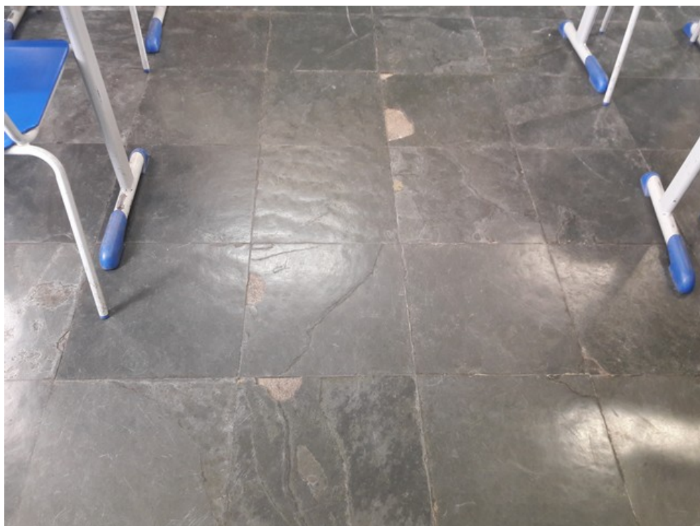
Piso da sala de aula
