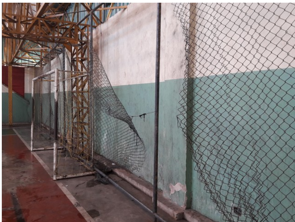
Alambrado da quadra
