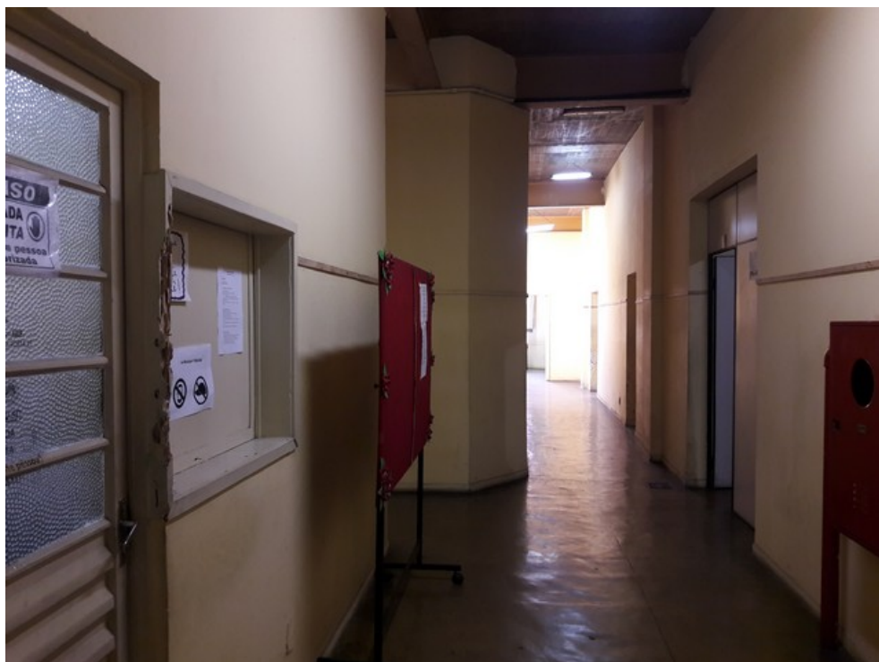
Corredor de acesso às salas
