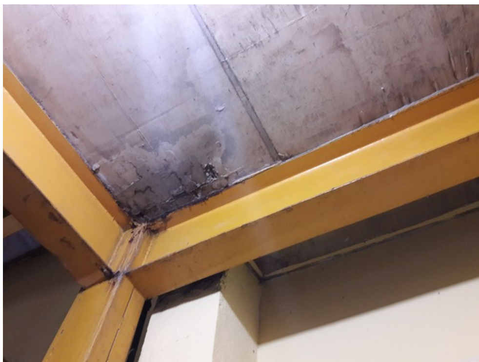
Teto da escada para acesso ao segundo andar
