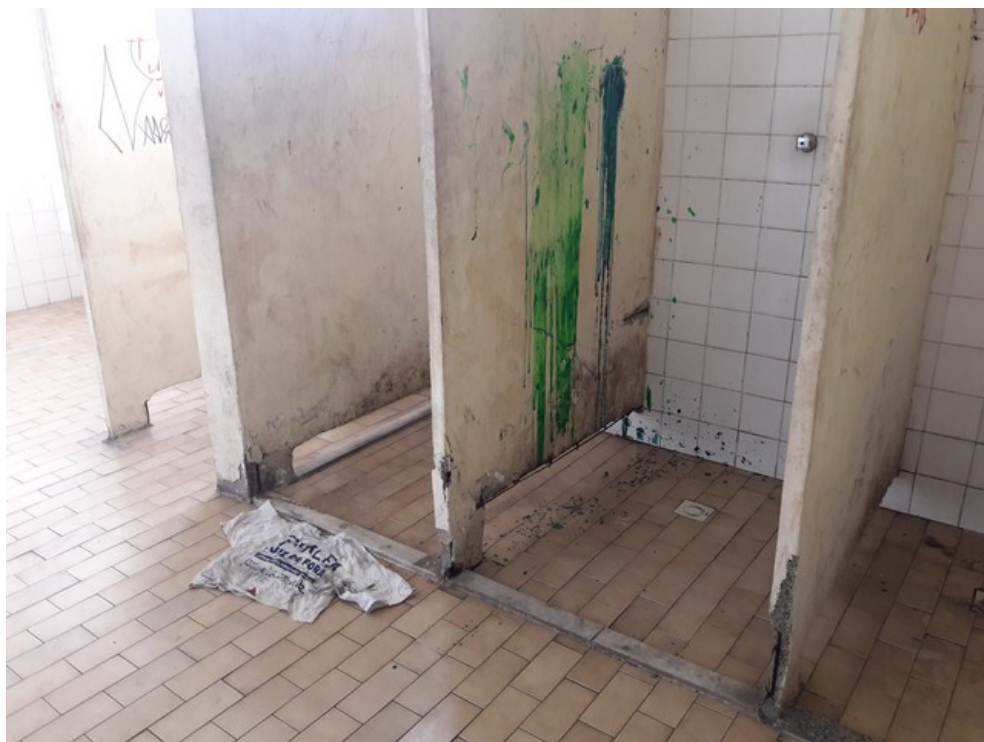
Vestiário da quadra
