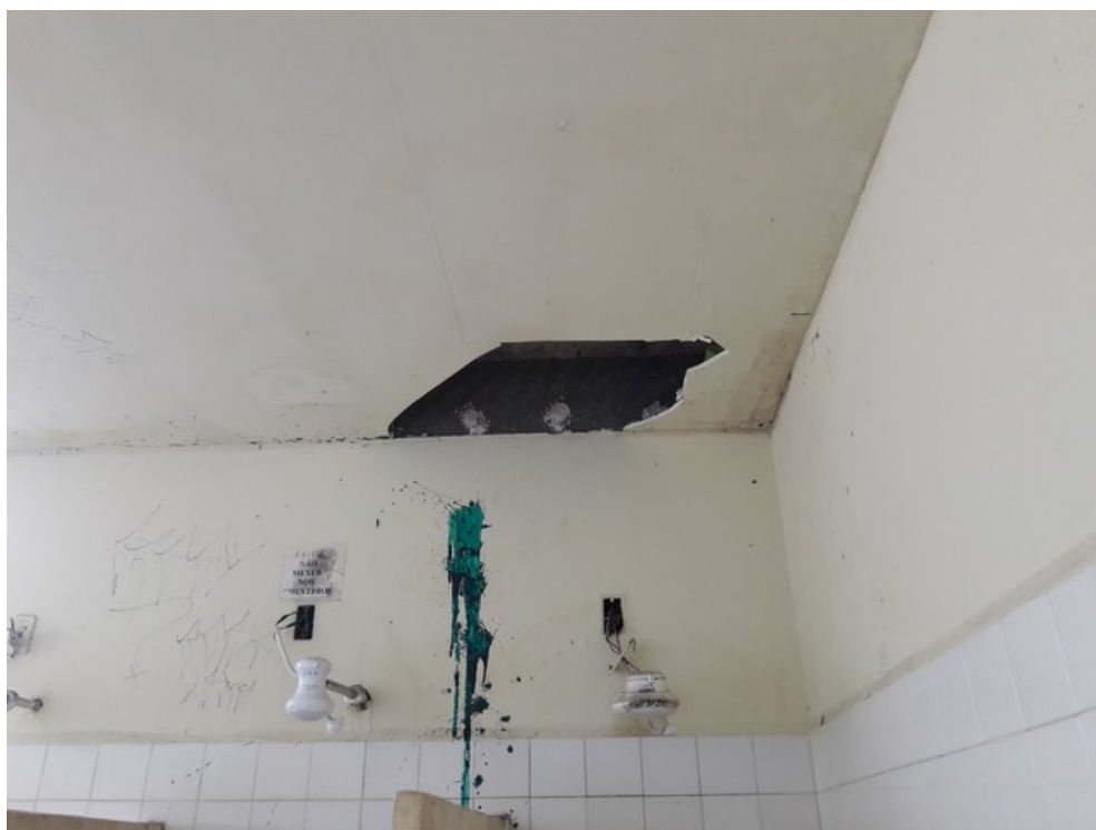
Teto do vestiário da quadra
