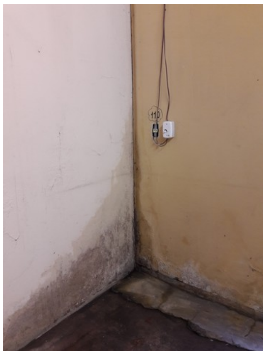
Parede da sala de artes
