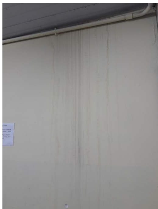
Parede da sala de coordenação
