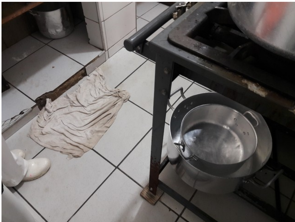
Chão da cozinha
