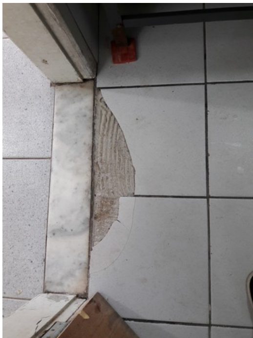
Chão da cozinha
