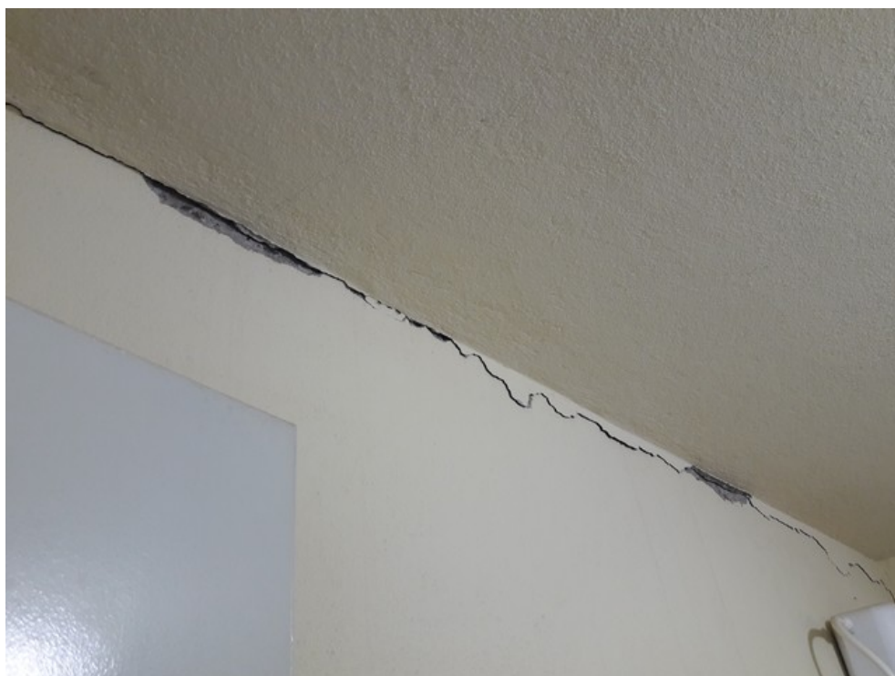
Teto do banheiro feminino dos professores
