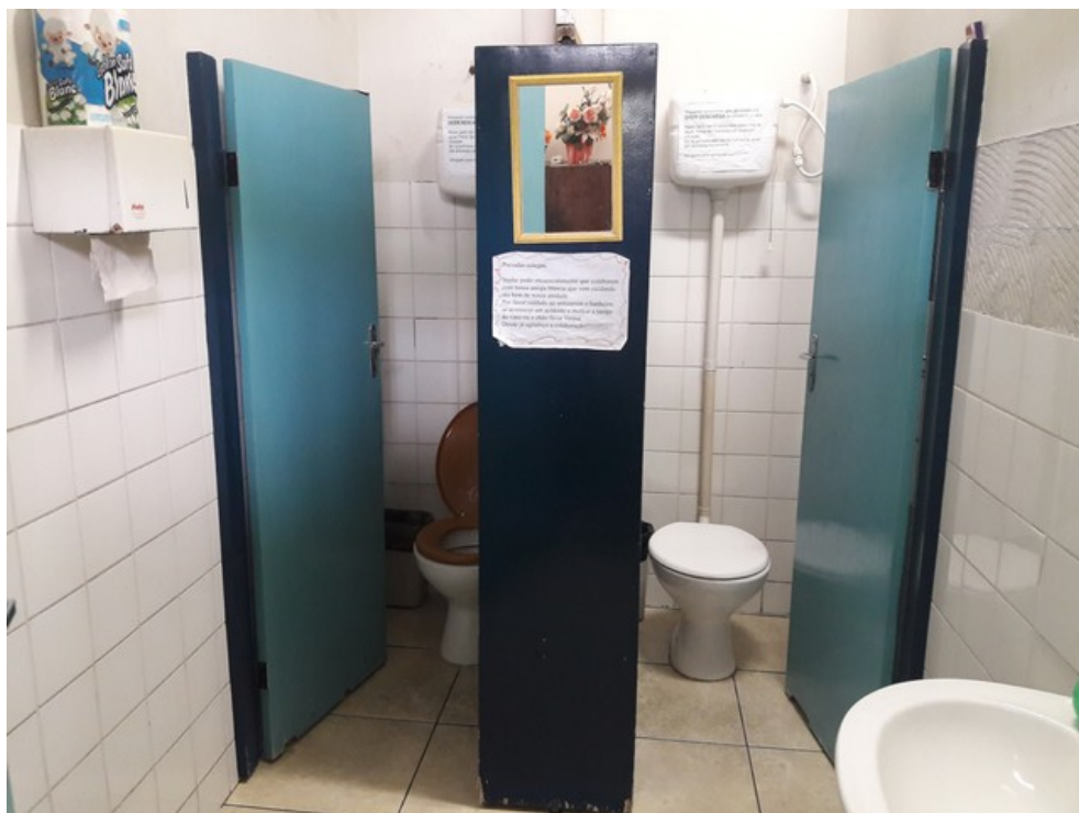
Banheiro dos funcionários
