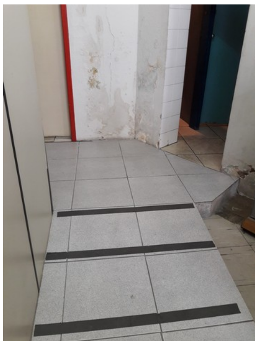
Rampa de acesso aos banheiros
