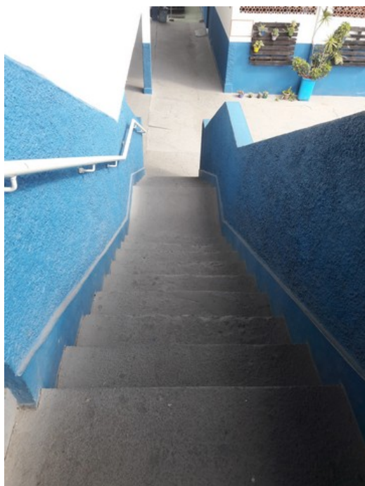
Escada para acesso ao segundo andar
