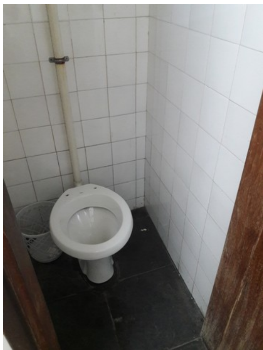
Banheiro masculino dos alunos (banheiro da quadra)
