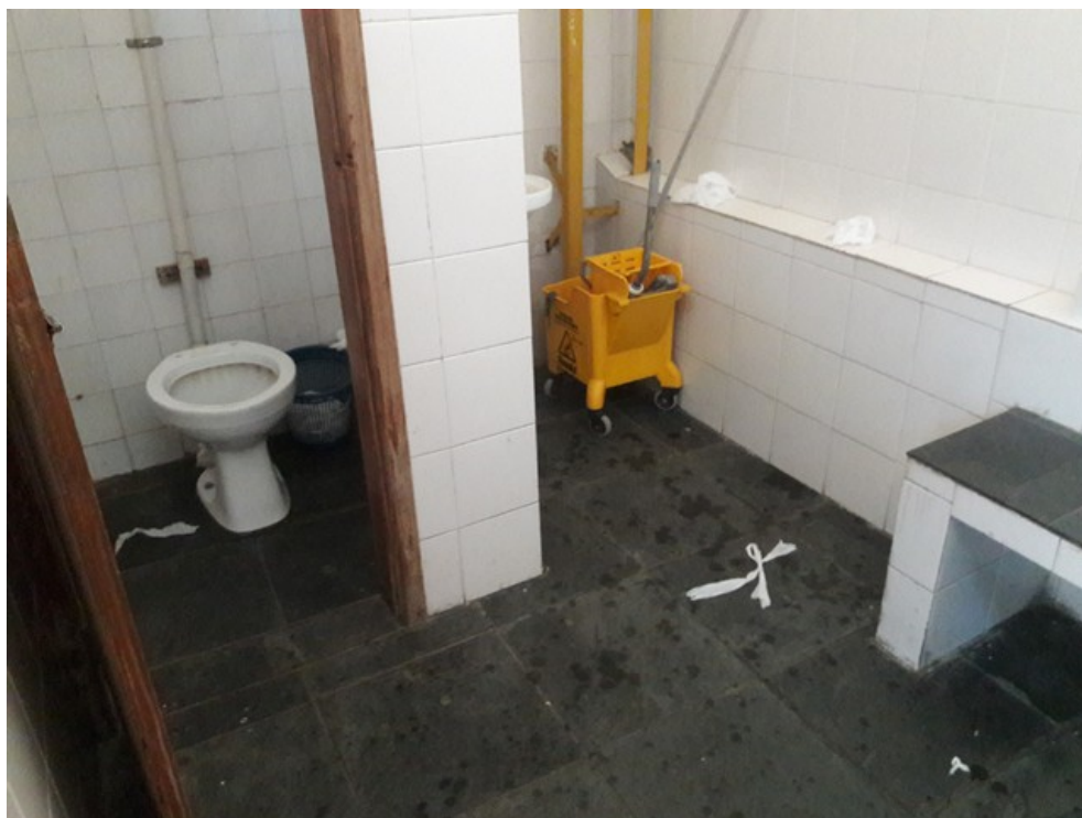
Banheiro feminino dos alunos (banheiro da quadra)
