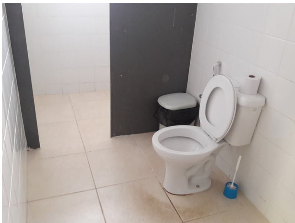
Banheiro masculino dos funcionários
