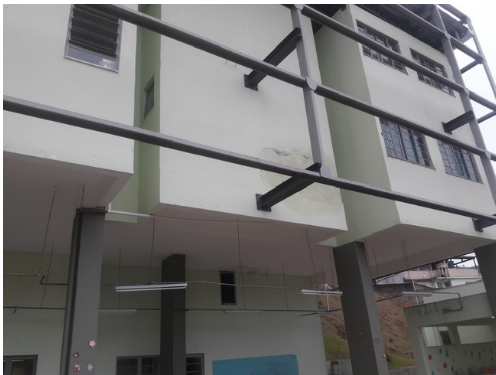
Fachada da creche
