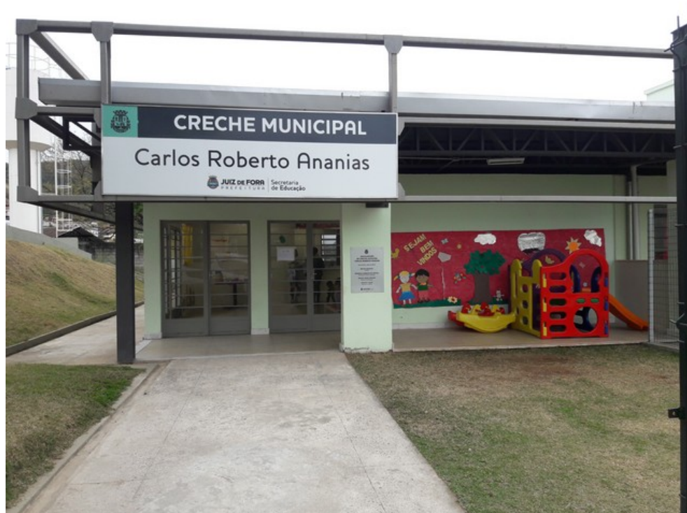
Fachada da creche
