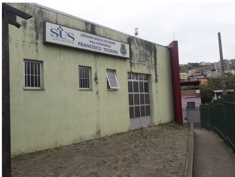
Fachada da unidade
