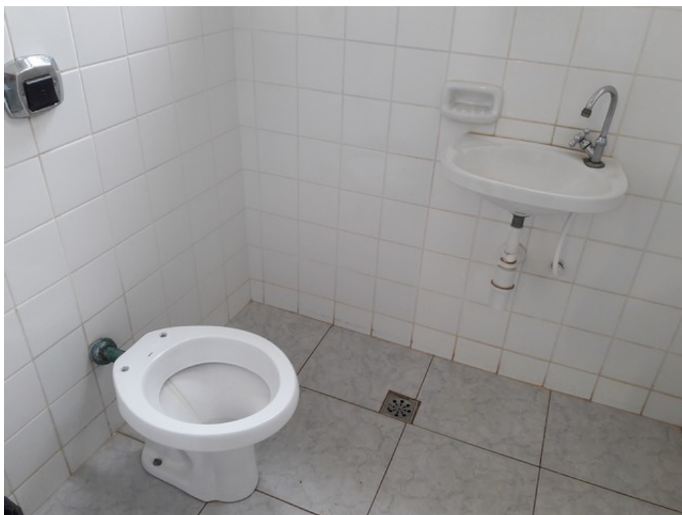
Banheiro masculino dos usuários
