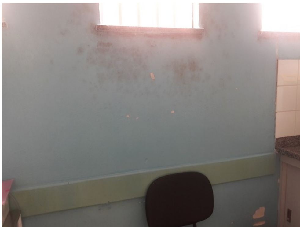
Parede da sala de coleta/preparo/inalação
