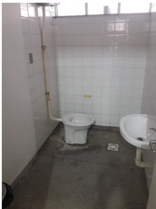
Banheiro dos funcionários
