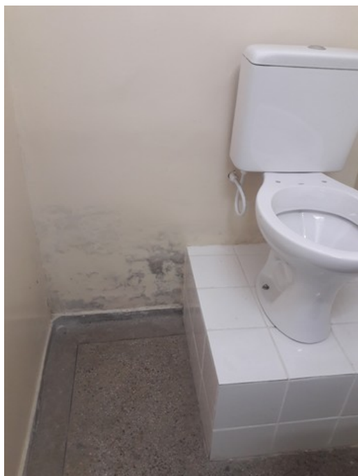
Parede do expurgo
