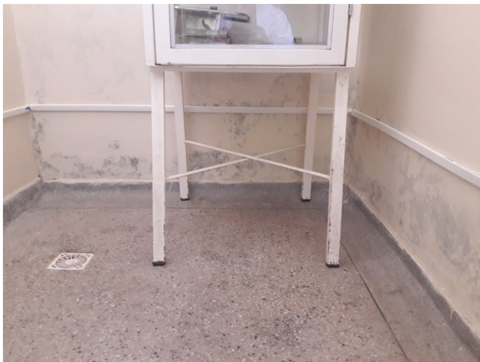
Parede da sala de esterilização
