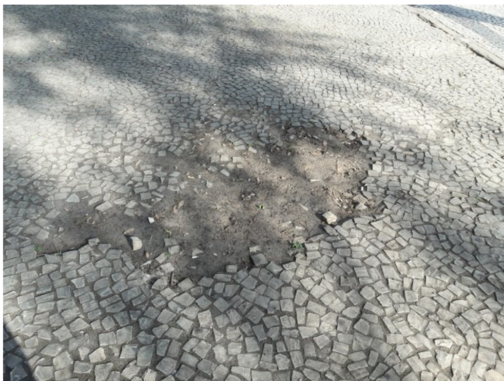
Parte do piso da praça
