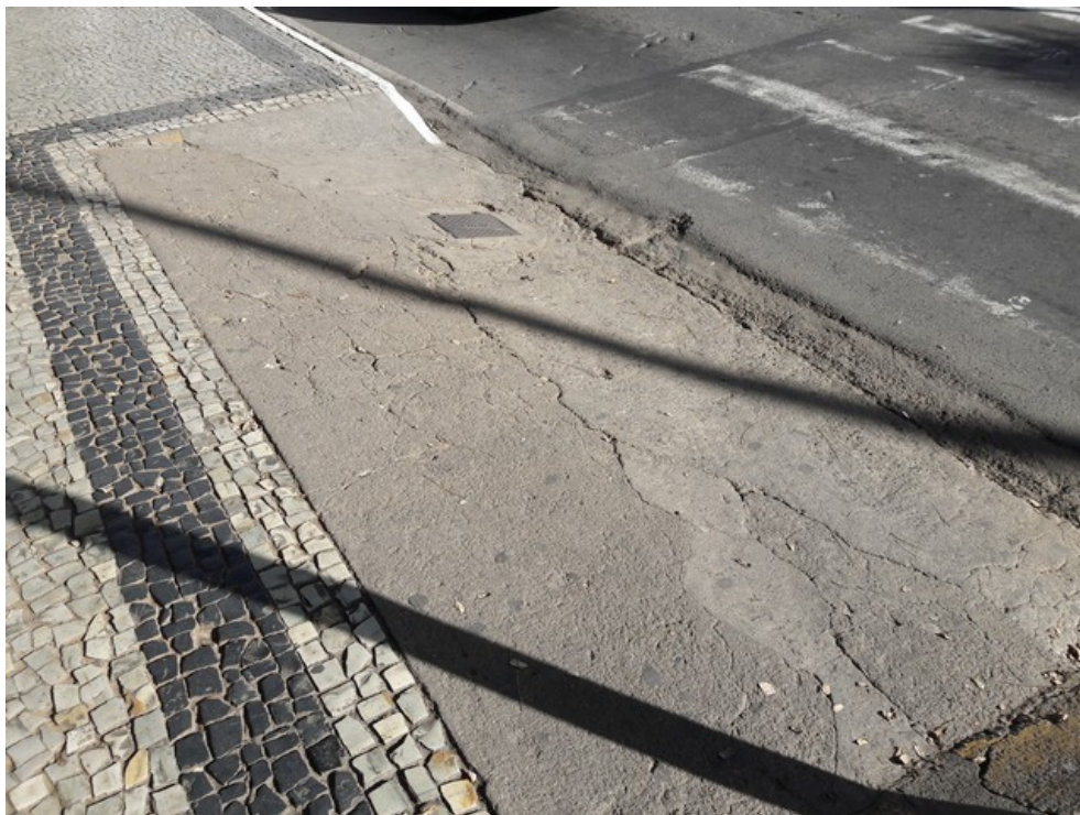
Rampa de acesso à praça
