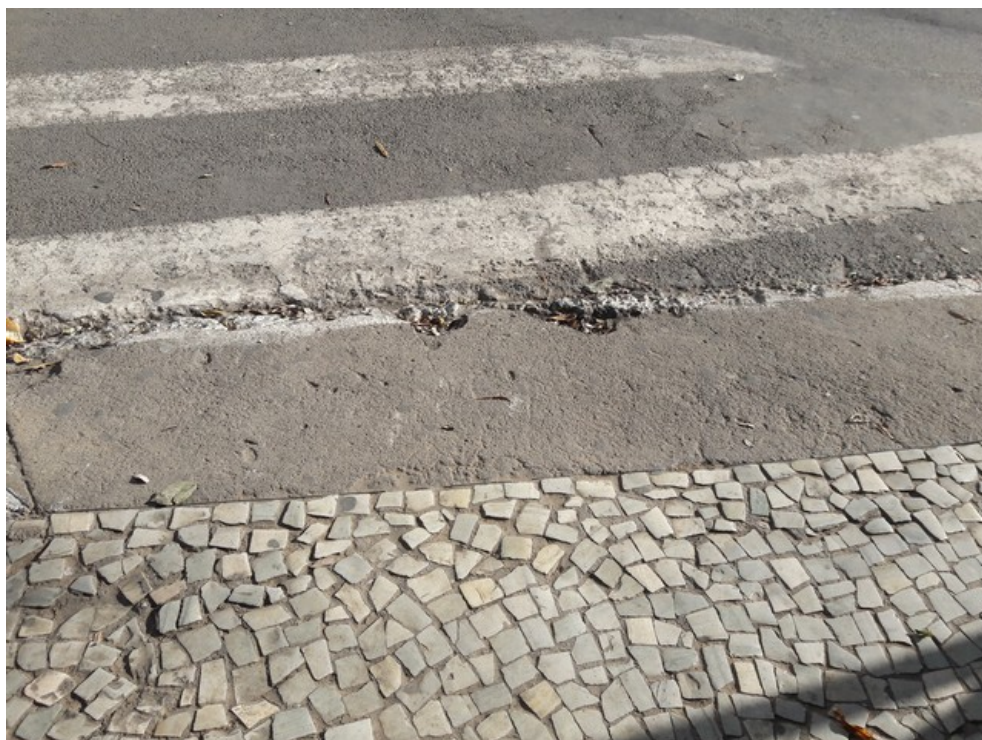
Rampa de acesso à praça
