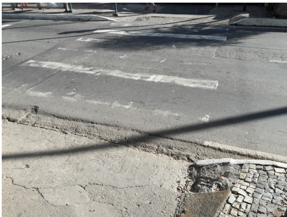
Rampa de acesso à praça
