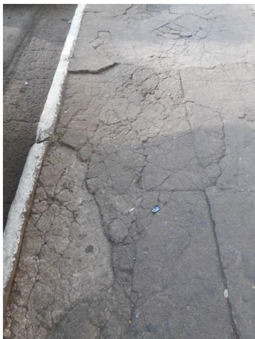
Parte do piso da praça
