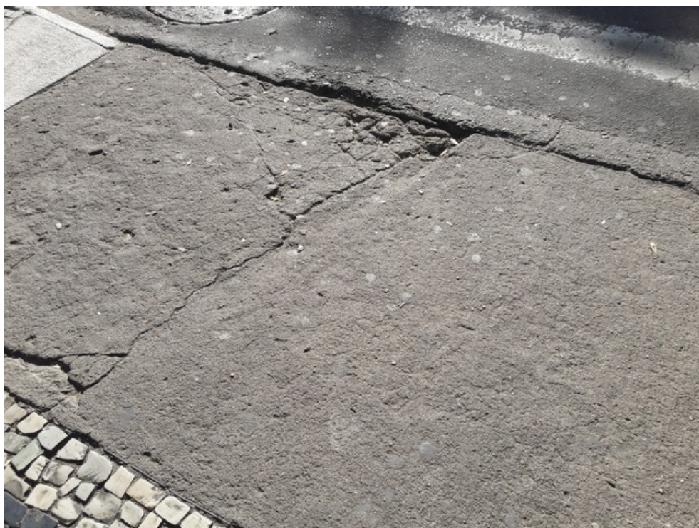
Rampa de acesso à praça
