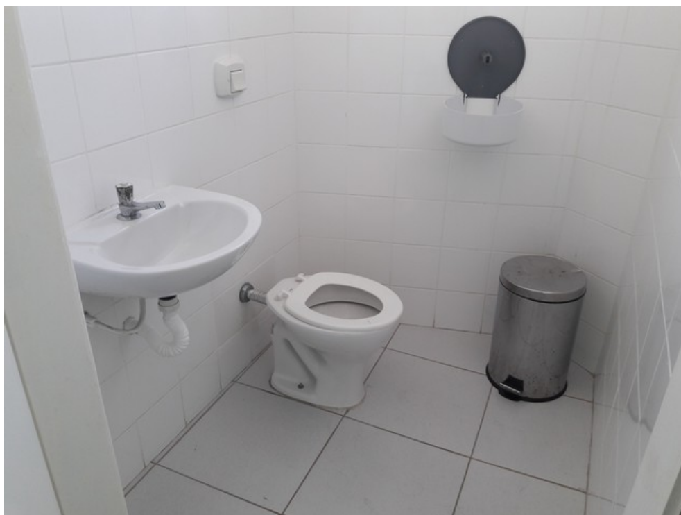
Banheiro do consultório ginecológico
