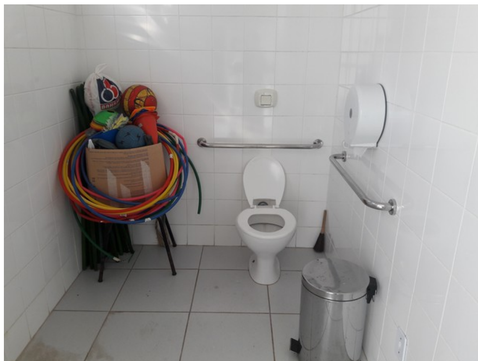
Banheiro unissex dos funcionários (adaptado)
