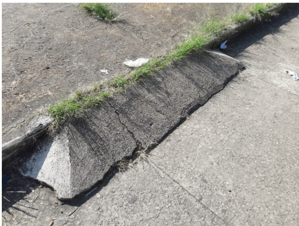
Rampa de acesso à praça
