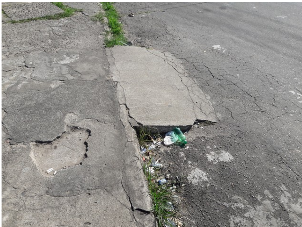
Rampa de acesso à praça
