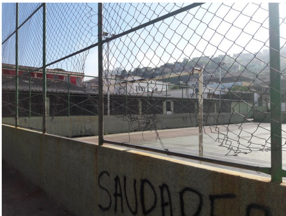
Alambrado da quadra de esportes
