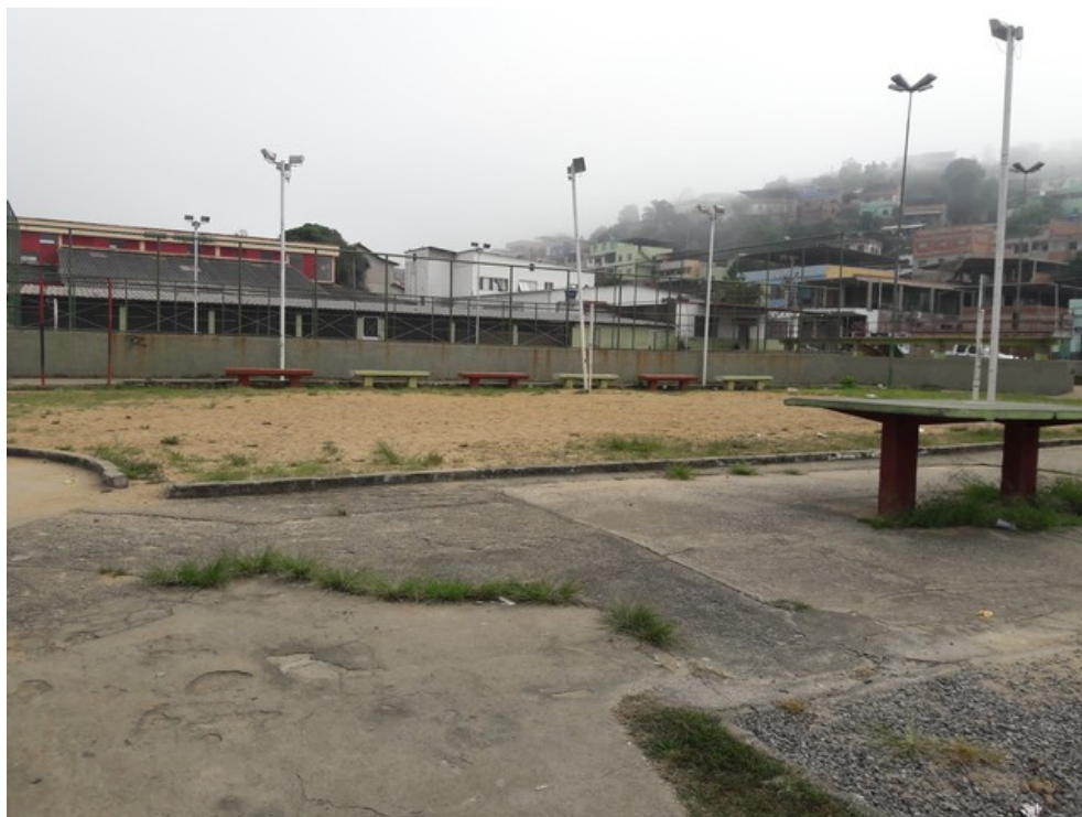
Vista geral da praça
