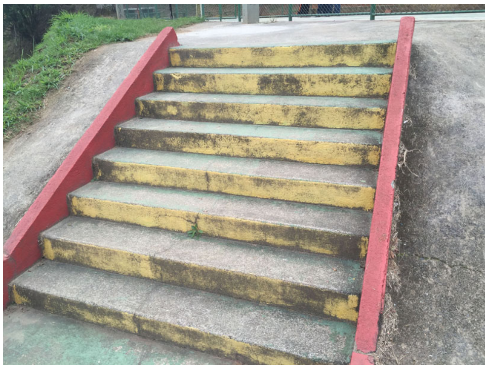
Escada de acesso à quadra
