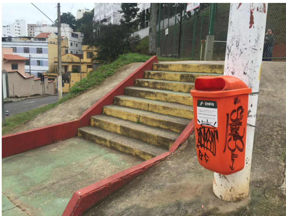
Escada de acesso à quadra
