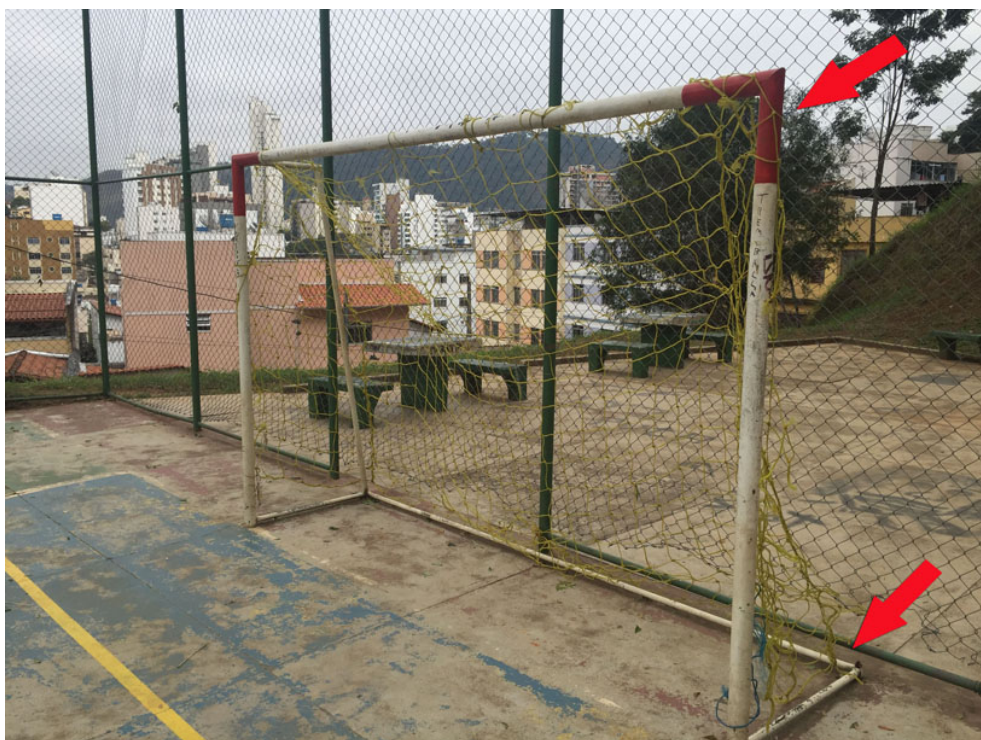
Trave danificada - Vista Lateral
