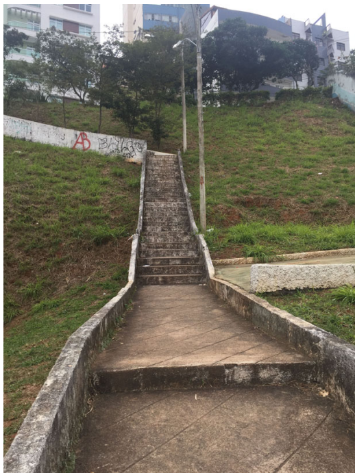
Escada de acesso à quadra pela rua Professora Carolina Coelho
