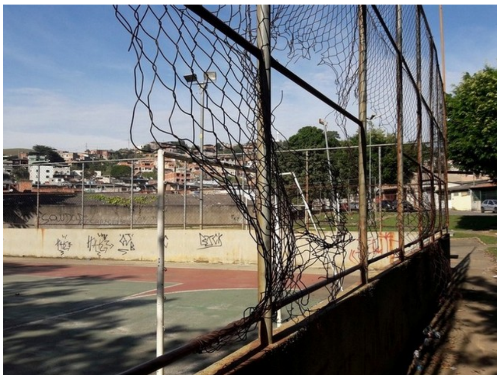
Alambrado da quadra de esportes
