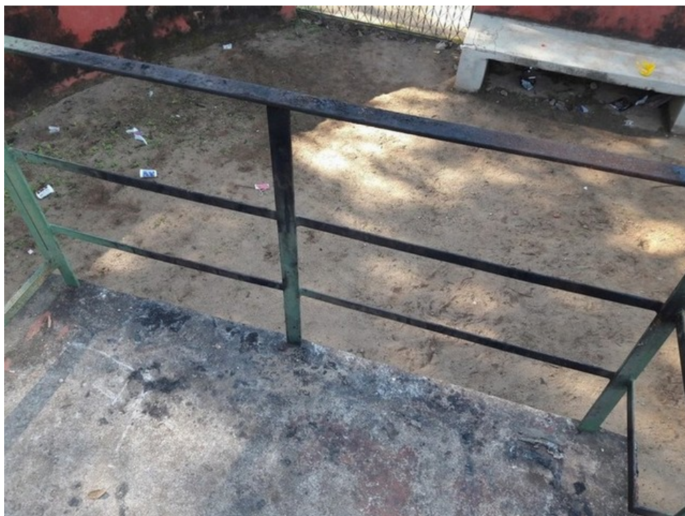
Grade da estrutura
