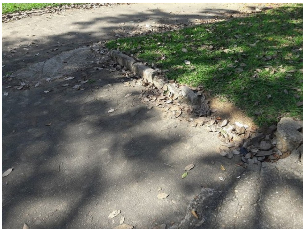
Rampa de acesso à praça
