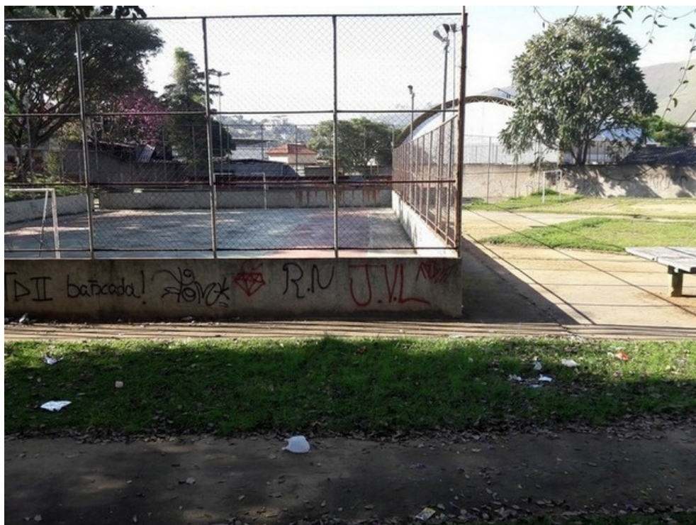
Vista geral da praça
