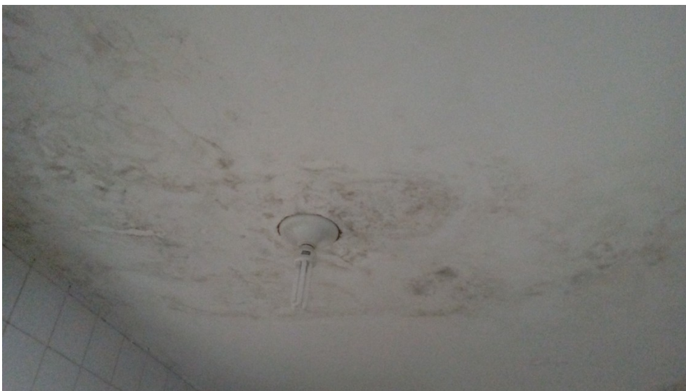
Teto do banheiro masculino
