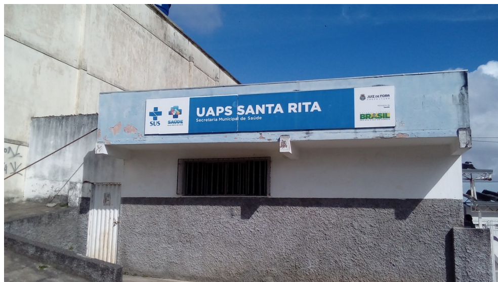
Fachada da unidade
