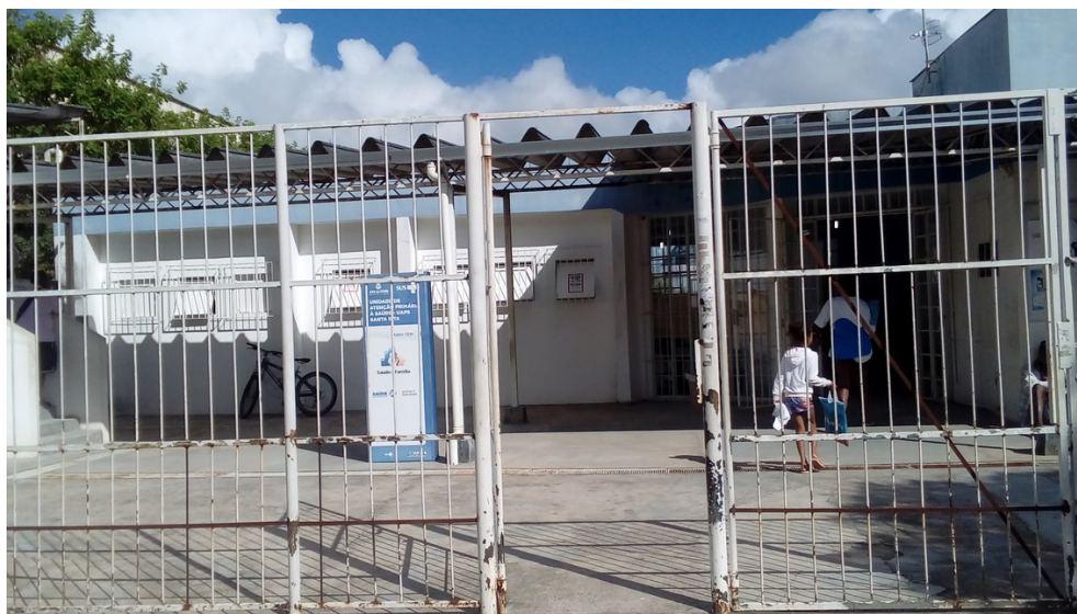
Fachada da unidade
