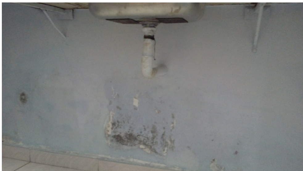
Parede da sala de vacina
