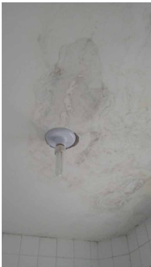
Teto do banheiro feminino
