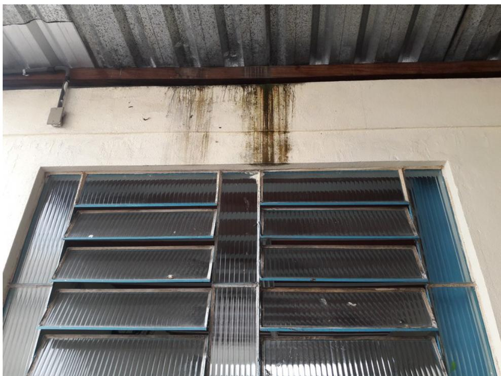
Infiltração parede externa de uma das salas
