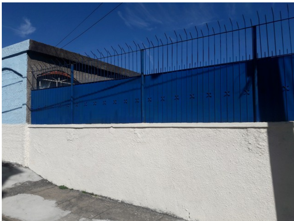
Muro da escola (prédio principal)
