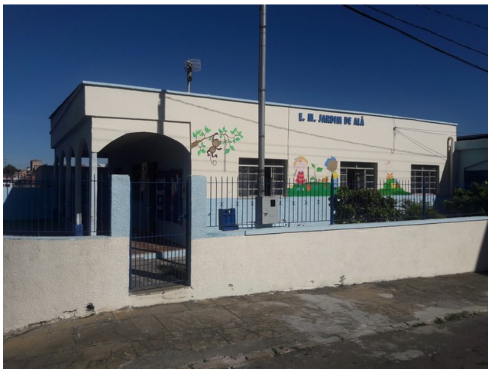
Frente da escola (prédio principal)
