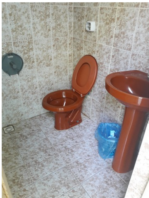
Banheiro masculino do anexo
