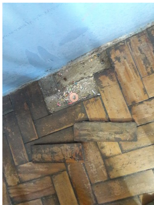
Piso da sala de aula
