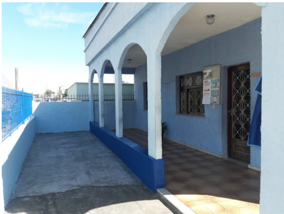
Varanda na entrada da escola (prédio principal)
