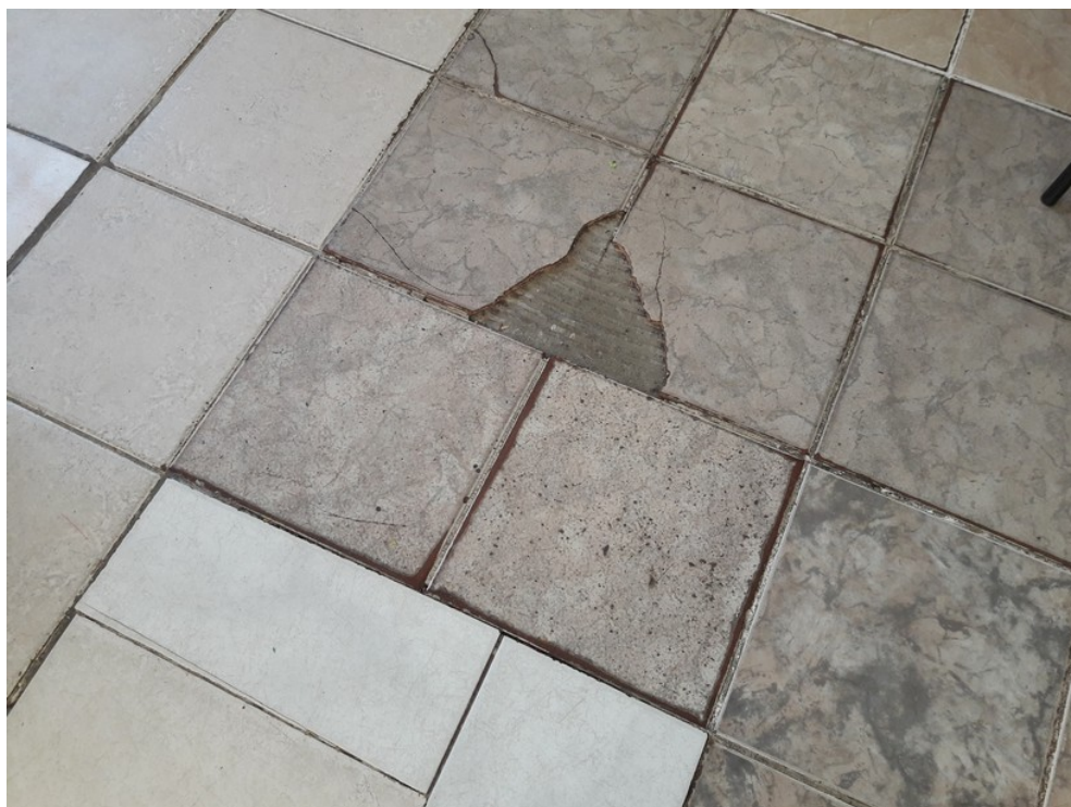
Piso da sala de aula
