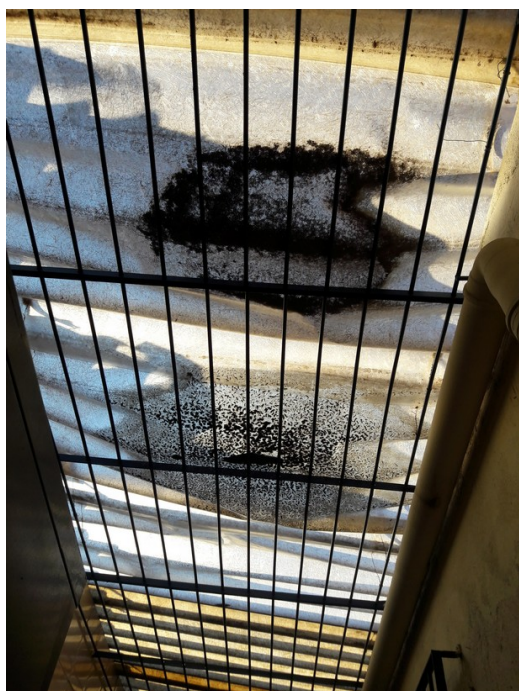
Teto do corredor para guarda de materiais diversos
