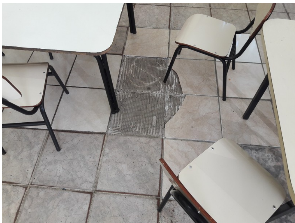
Piso da sala de aula
