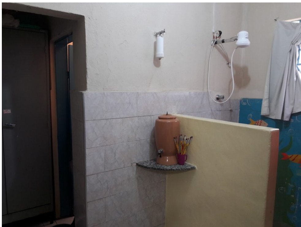
Banheiro da sala de aula
