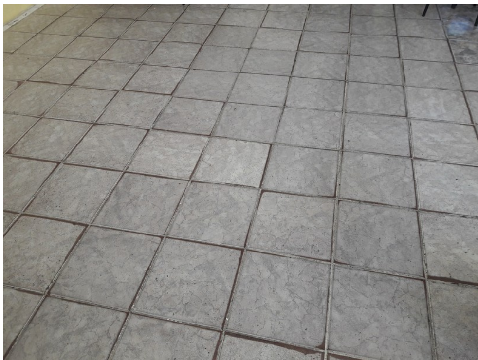
Piso da sala de aula
