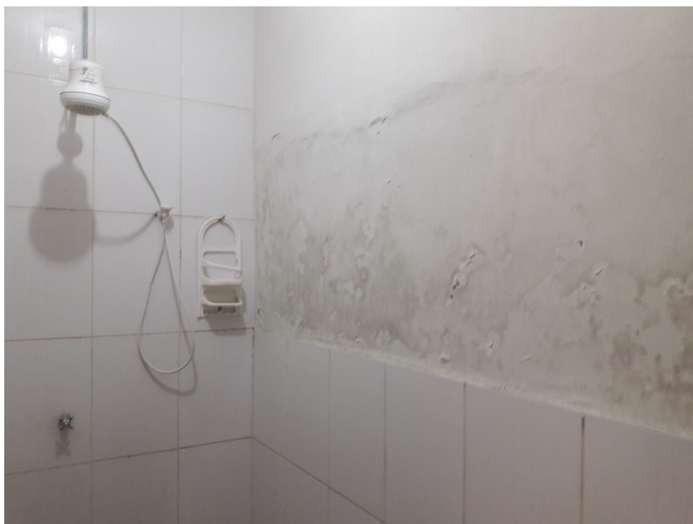
Banheiro dos funcionários
