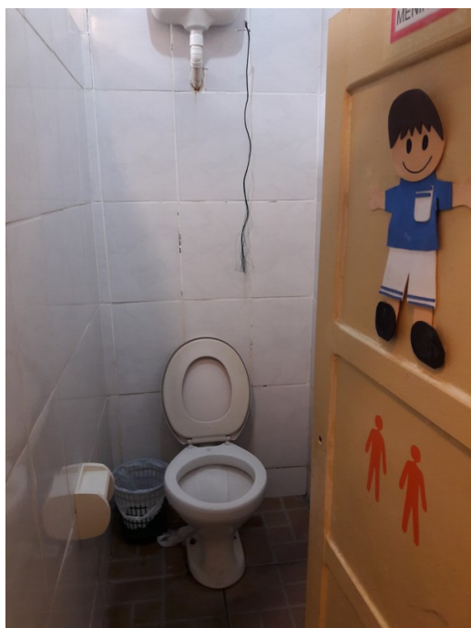
Banheiro da sala de aula
