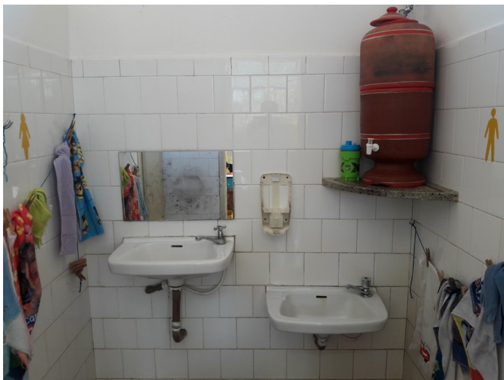
Banheiro da sala de aula
