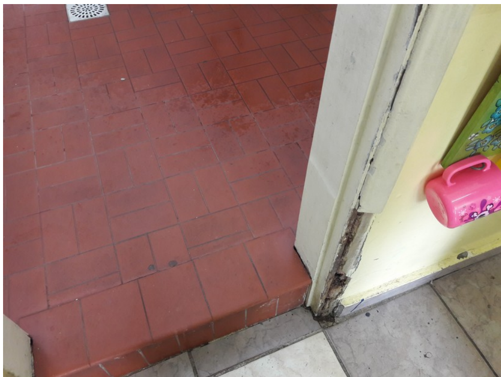
Porta do banheiro da sala de aula
