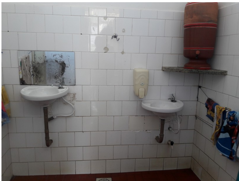
Banheiro da sala de aula
