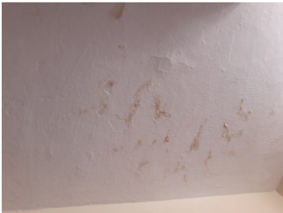
Teto da sala de leitura
