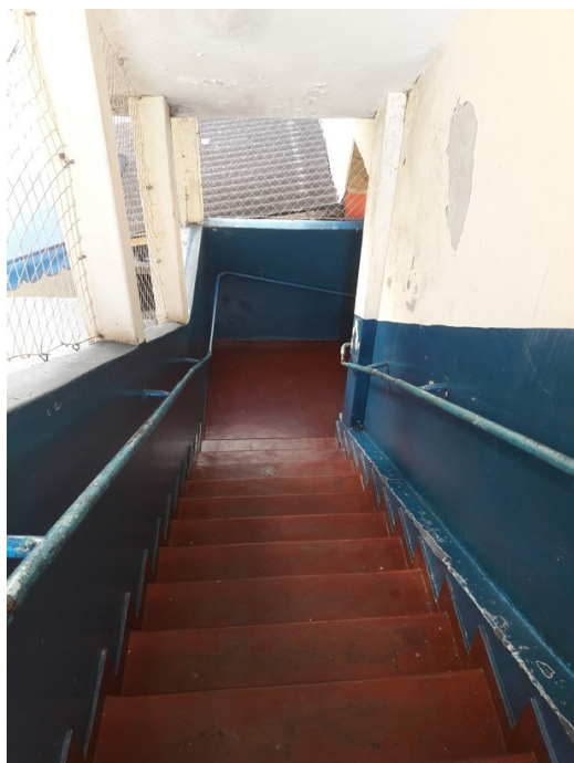
Escada para acesso ao segundo andar
