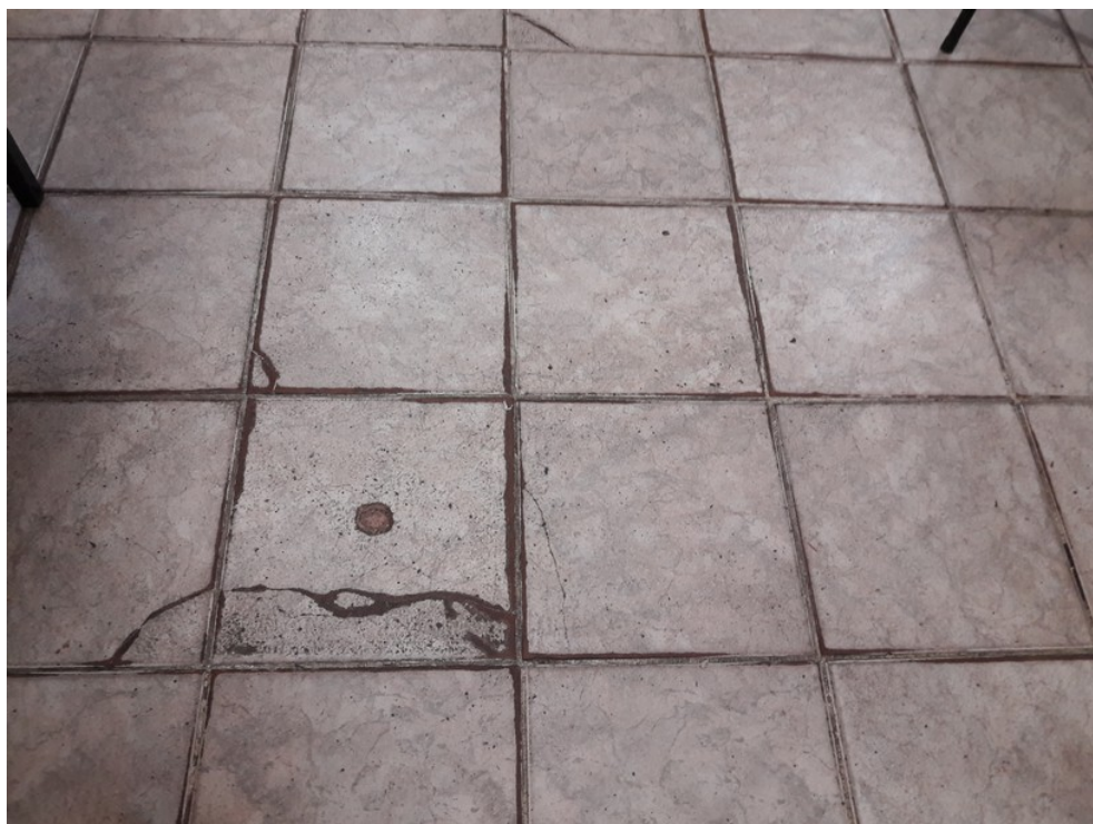
Piso da sala de aula
