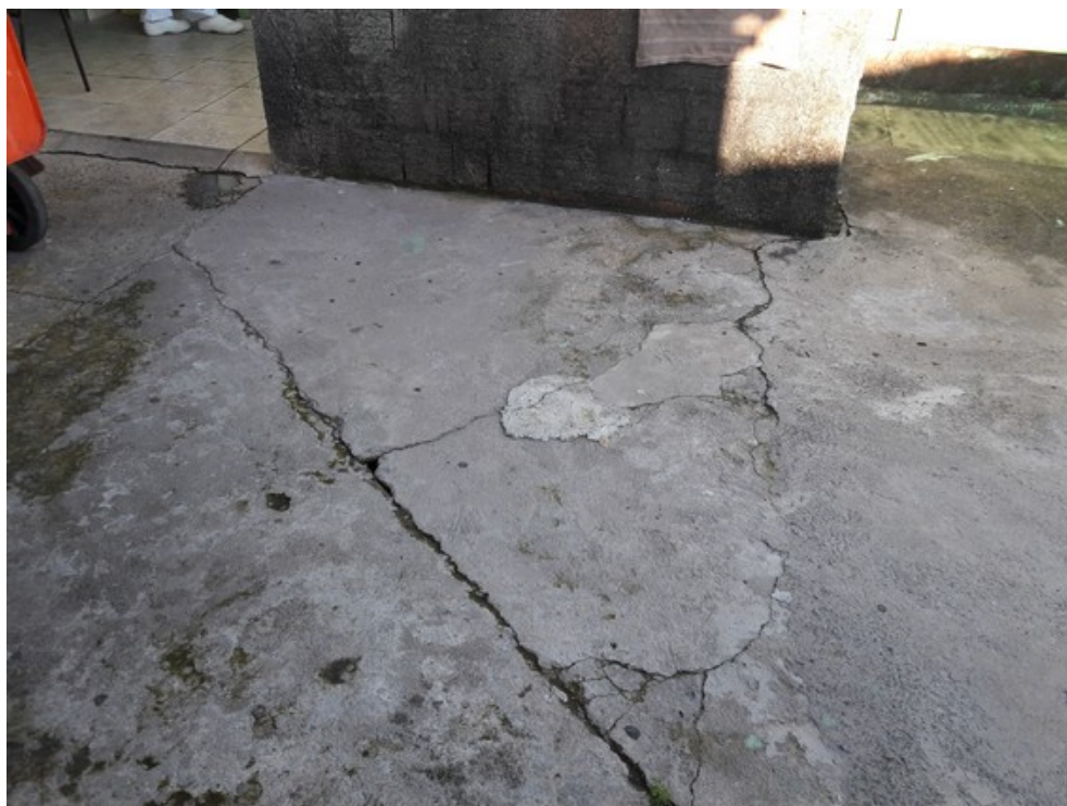
Chão da área externa da cozinha e dispensa
