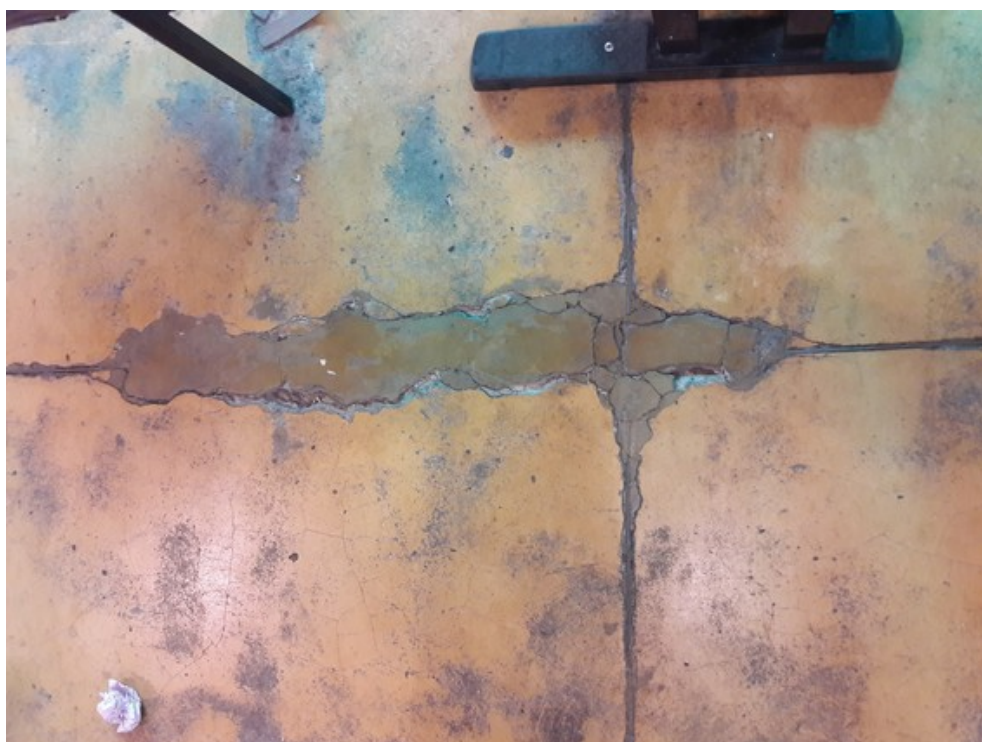
Chão da sala de aula
