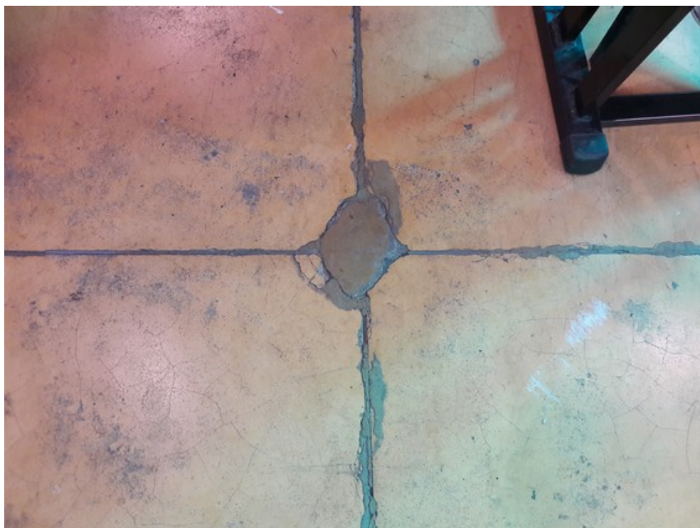
Chão da sala de aula
