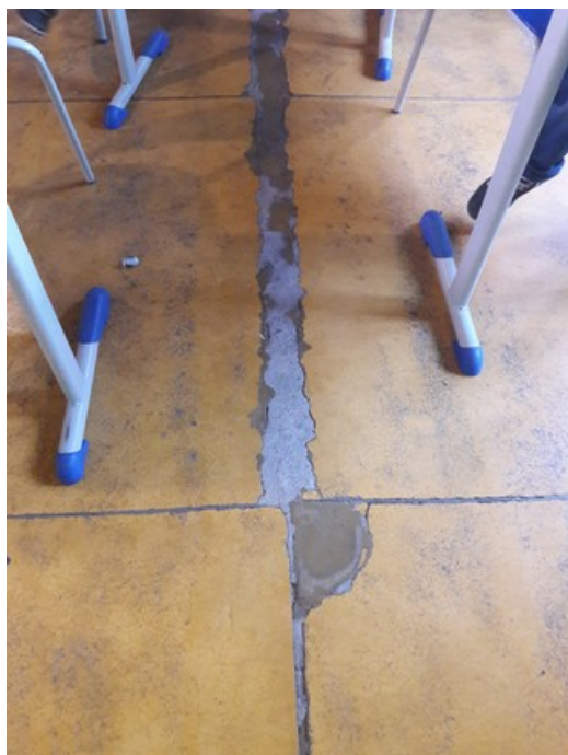
Chão da sala de aula
