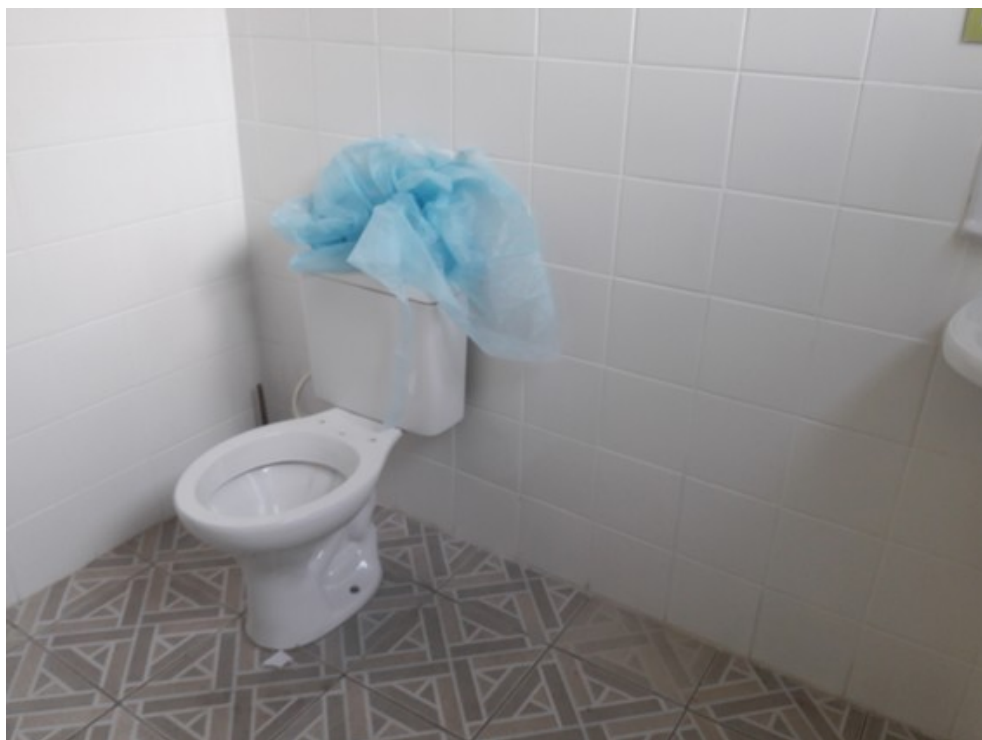
Banheiro do consultório ginecológico
