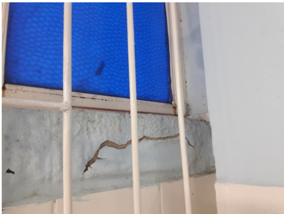
Parede da sala de vacinas
