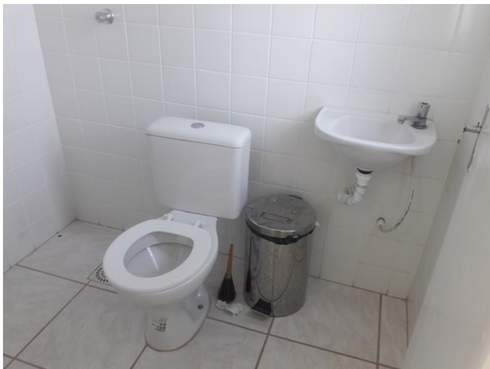
Banheiro do consultório ginecológico
