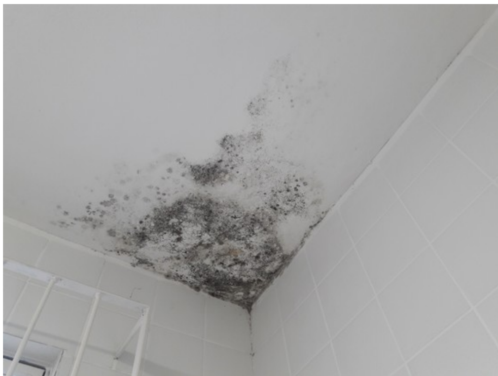
Teto da sala de esterilização
