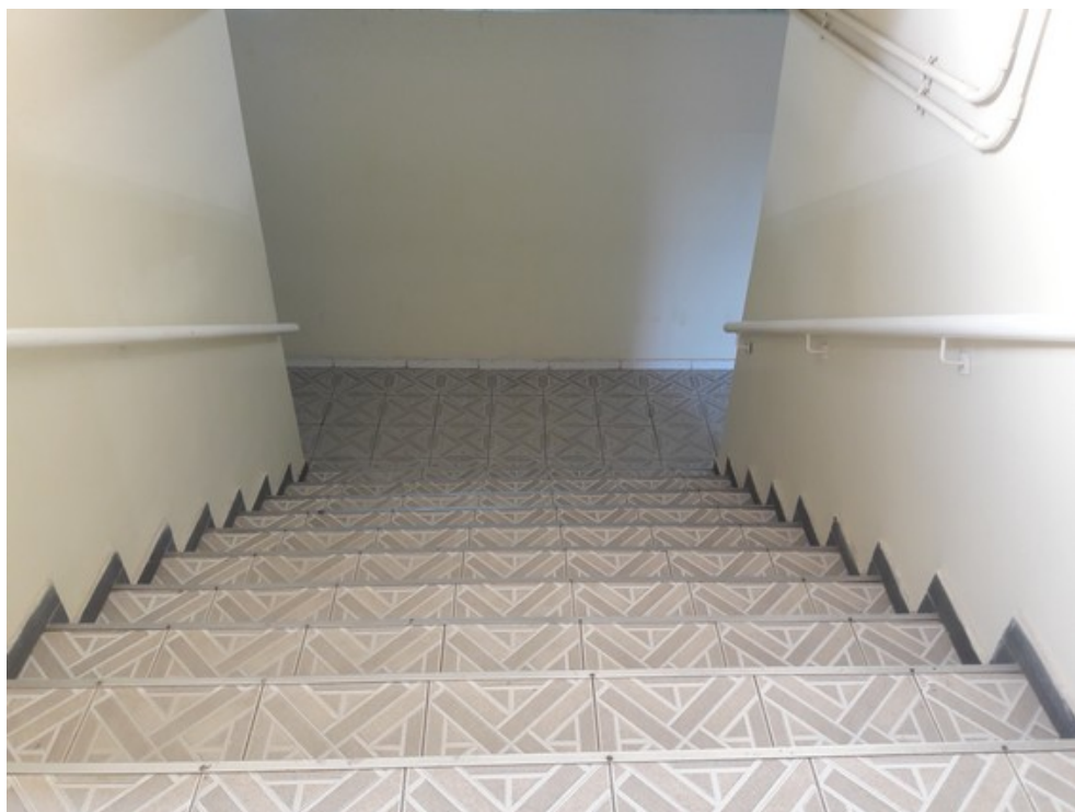
Escada para acesso ao segundo andar
