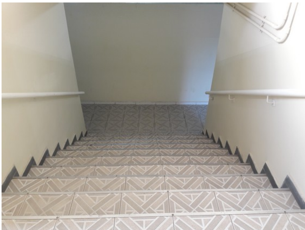
Escada para acesso ao segundo andar
