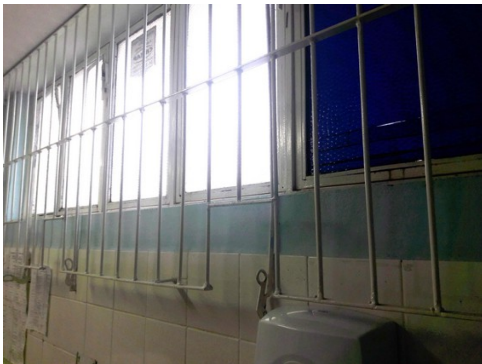
Janela da sala de vacinas
