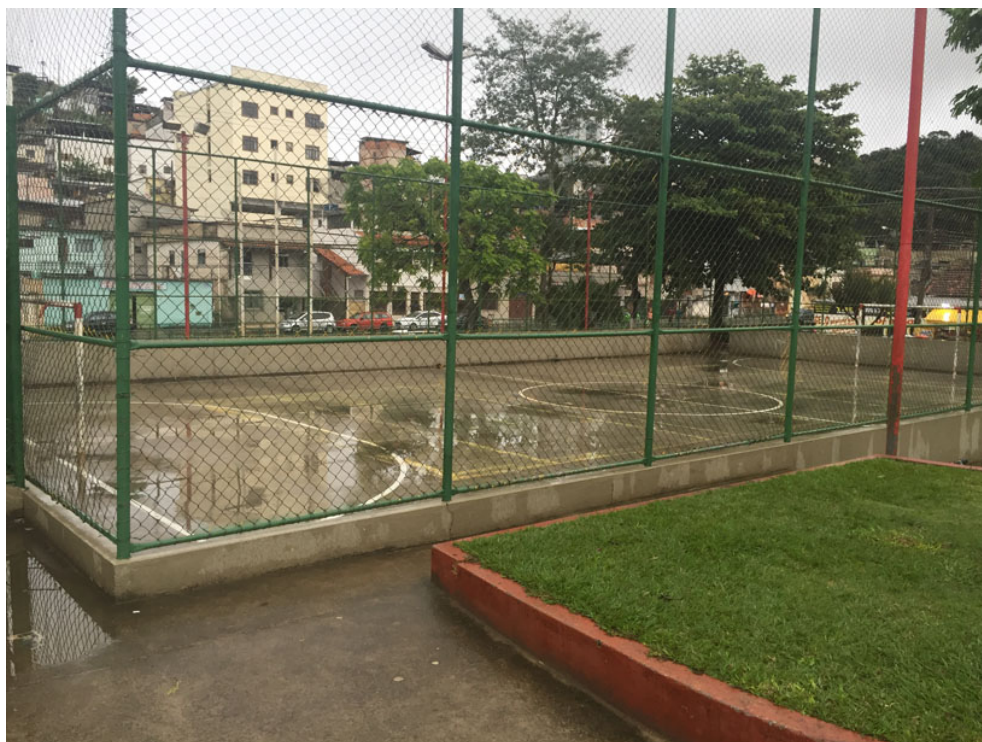
Alambrado da Quadra
