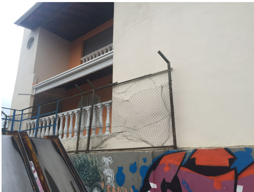
Grade de proteção do parquinho necessita de raparos
