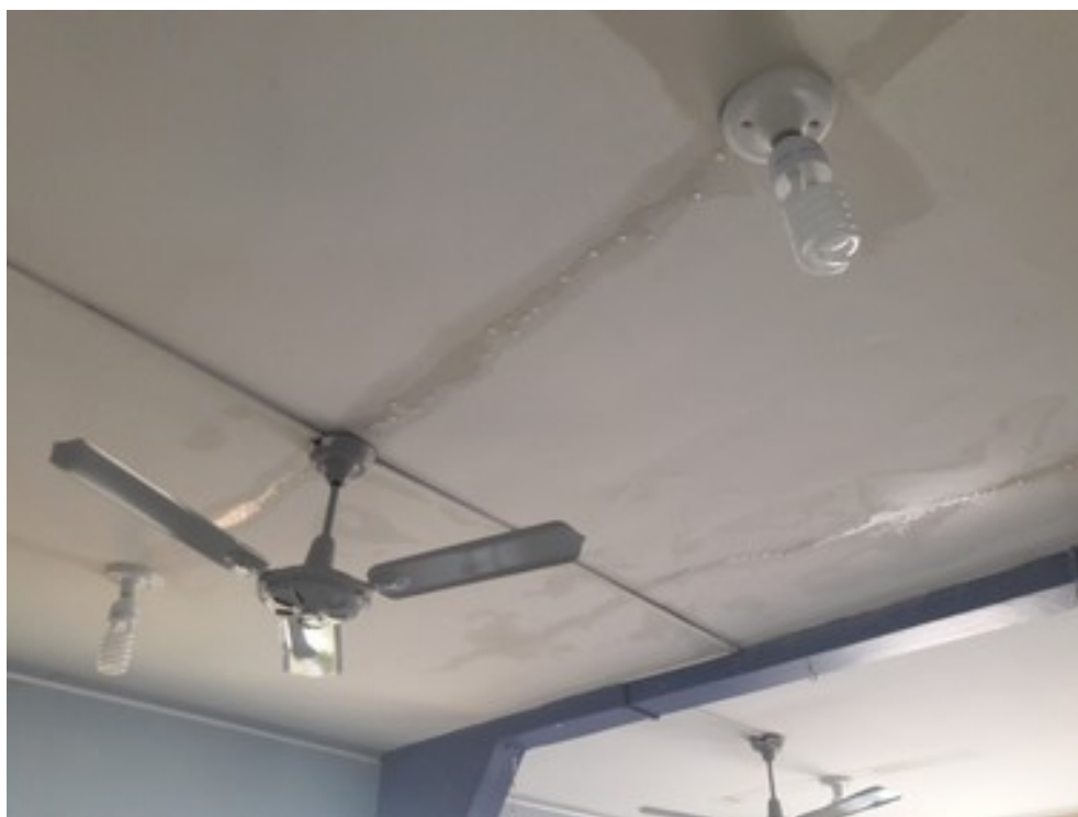
Teto da sala de direção/coordenação
