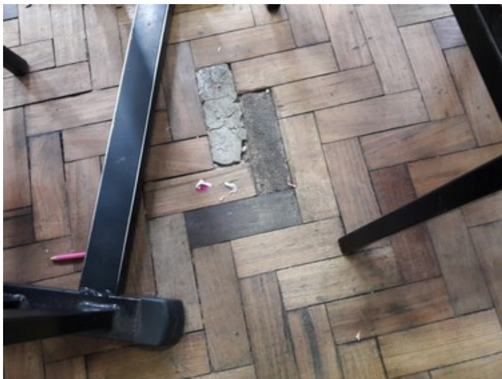
Piso da sala de aula
