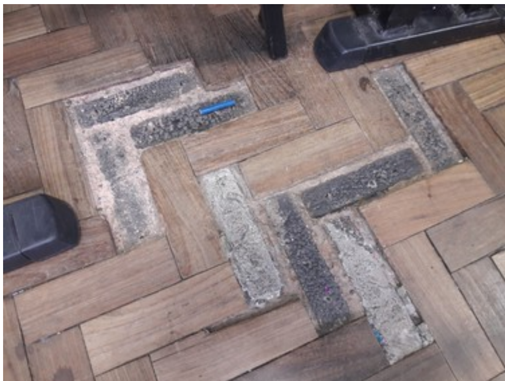
Piso da sala de aula
