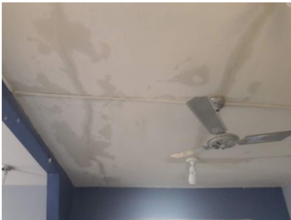
Teto da sala de direção/coordenação
