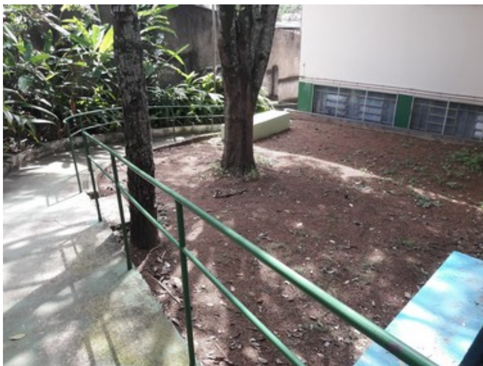
Rampa de acesso
