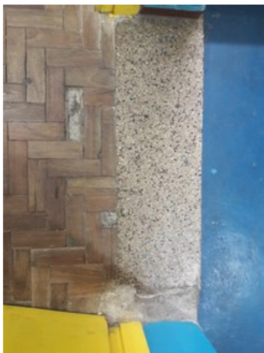
Piso da sala de aula
