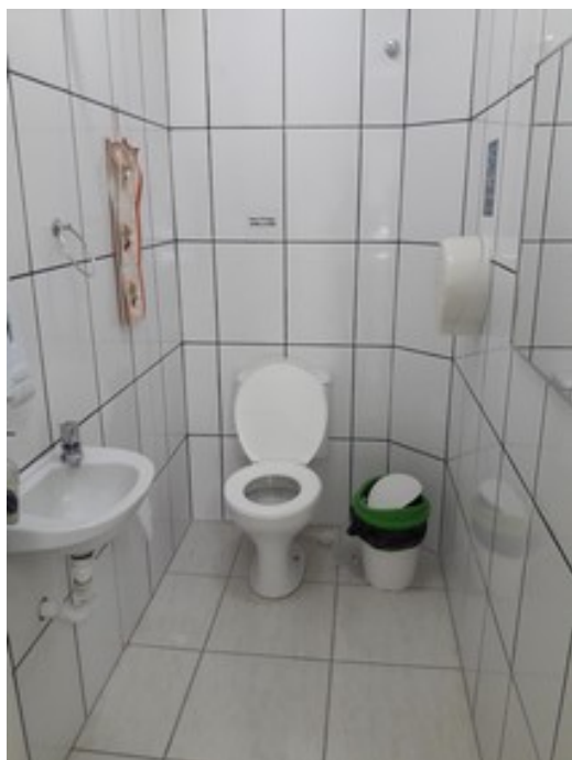
Banheiro dos funcionários
