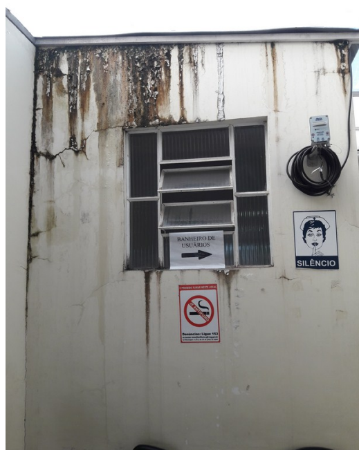
Parede externa dos banheiros de usuários
