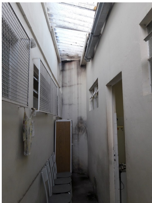
Corredor que dá acesso à copa/cozinha
