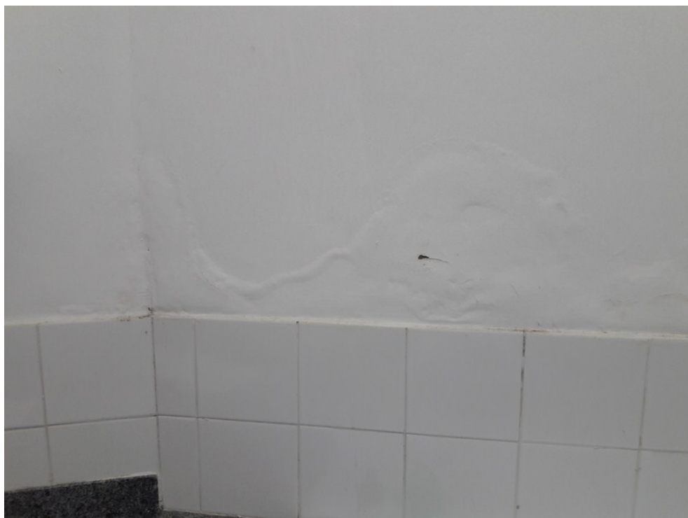
Sala de Esterilização
