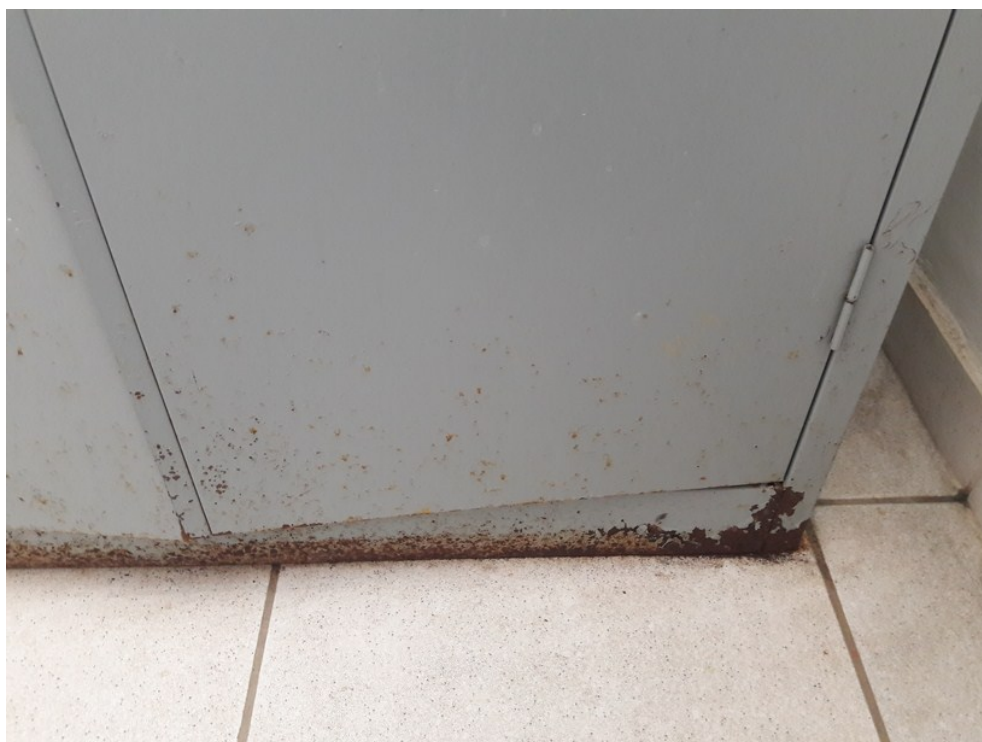
Sala de guarda de materiais
