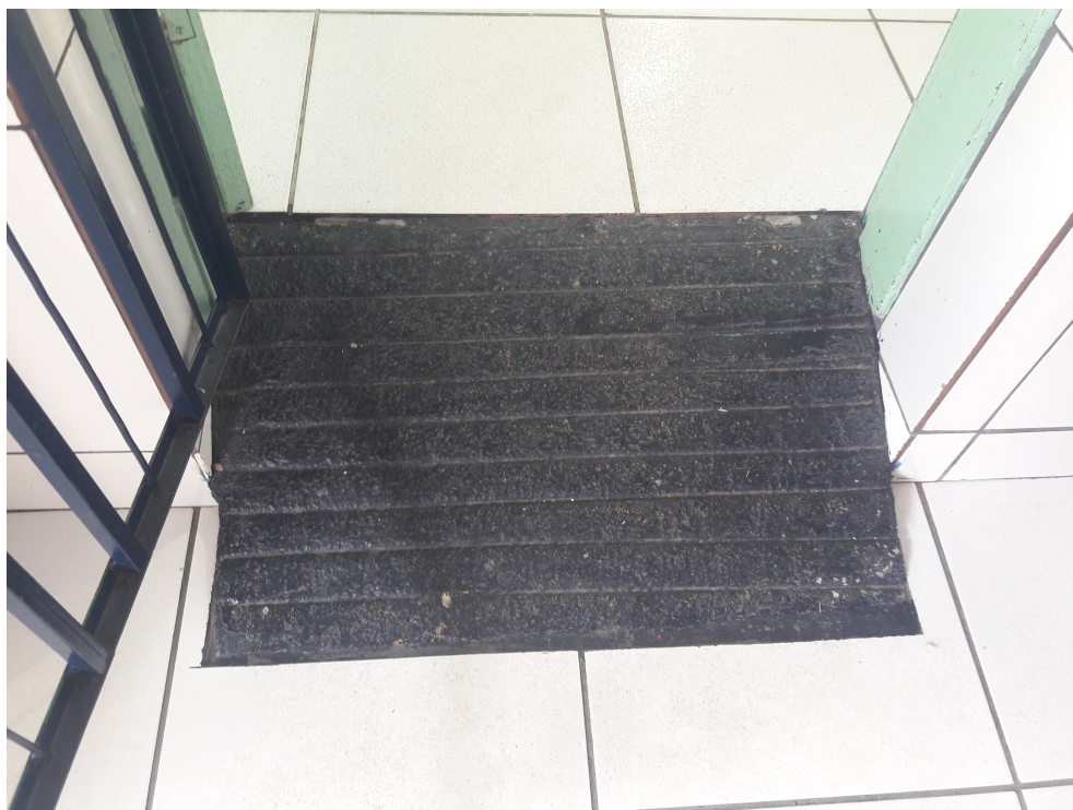
Rampa de acesso à sala
