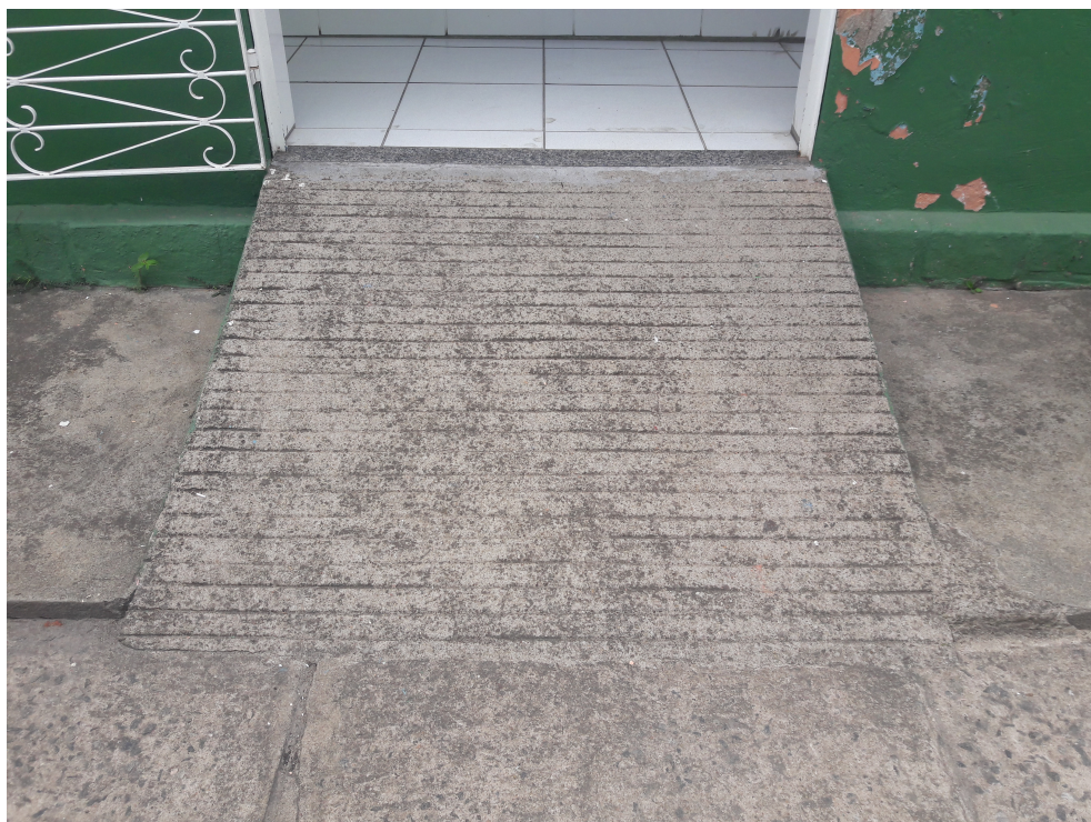
Rampa de acesso à sala
