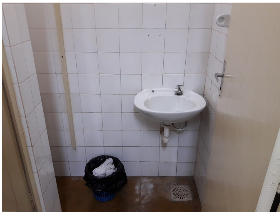
Banheiro da sala de aula
