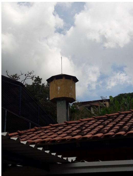
Caixa d'água com para-raio aparentemente sem aterramento
