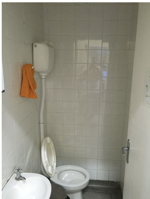
Banheiro Funcionários Masculino
