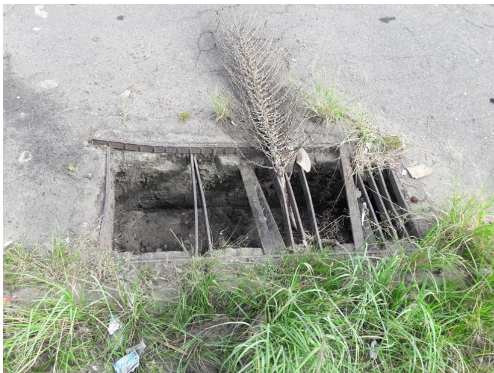
Bueiro na área de estacionamento
