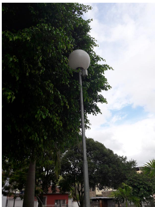
Iluminação da praça. Parcialmente coberta pela vegetação e possivelmente insuficiente.
