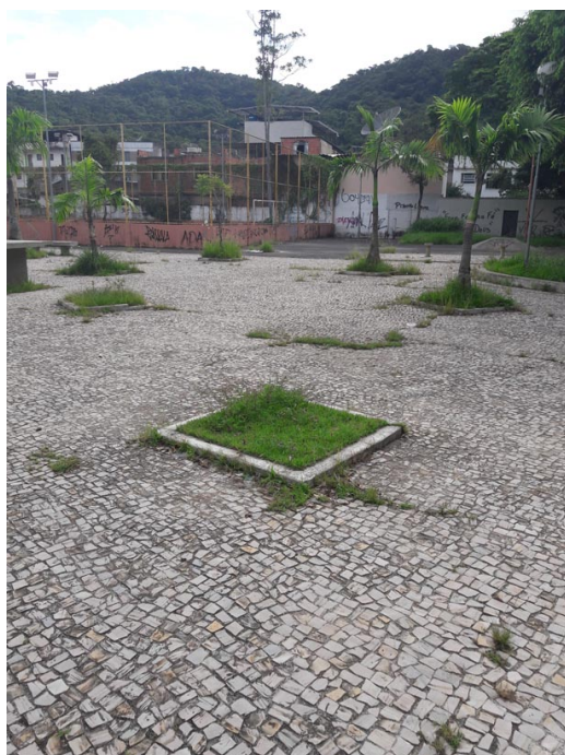
Piso. Boas condições. Necessita manutenção e reparos
