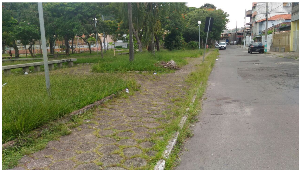
Área de Gramado. Necessita manutenção.
