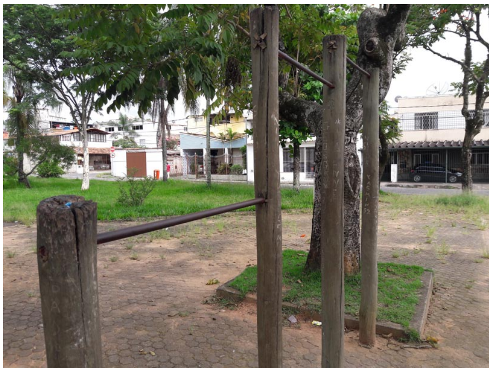
Área destinada à prática de atividades físicas. Sem condições de uso Necessita de repa
