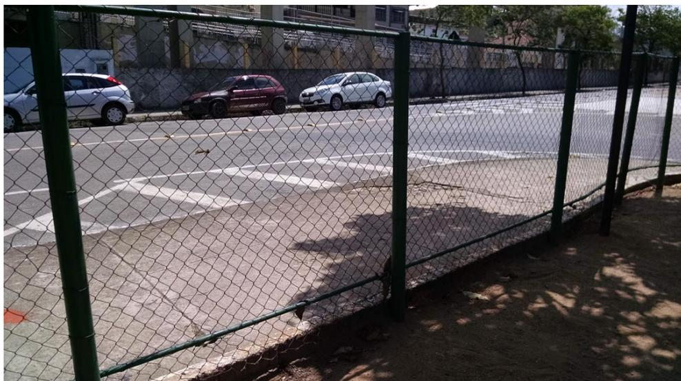
Grade do parquinho - necessita de fixação da tela na grade inferior devido às pontas de
