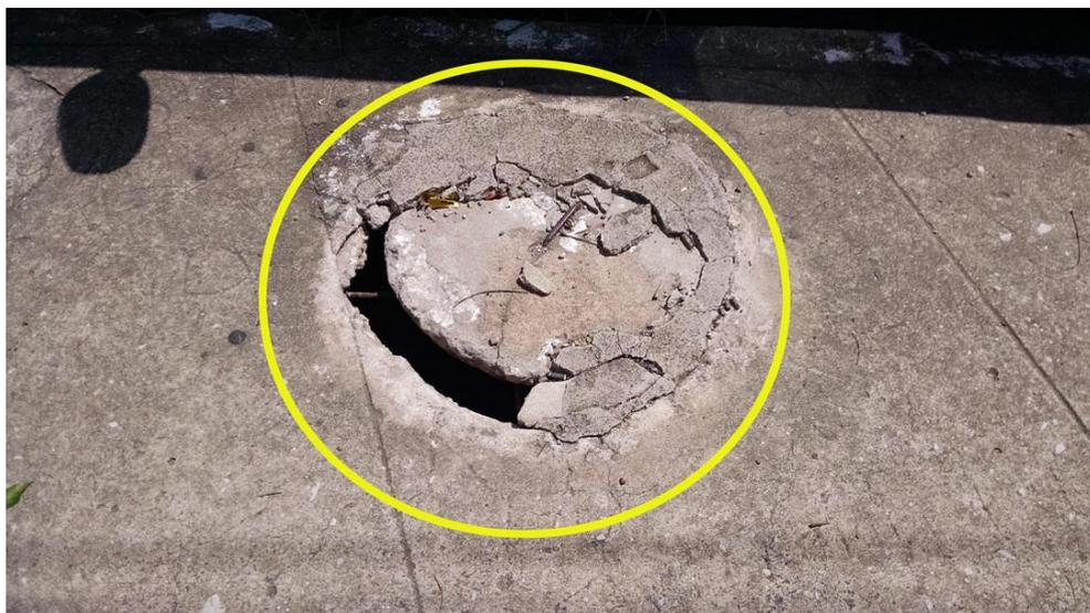
Tampa de água e esgoto necessitando de reparos
