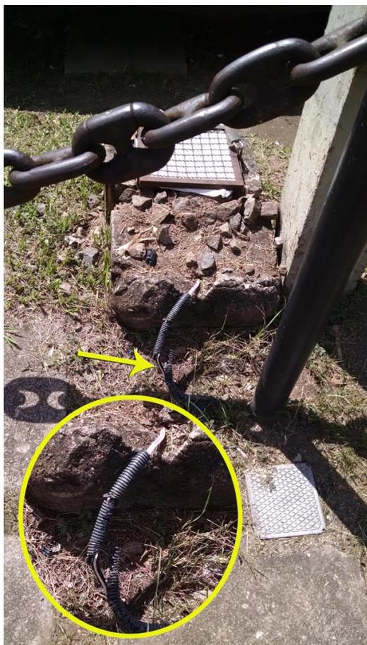
Sistema elétrico com fiação exposta
