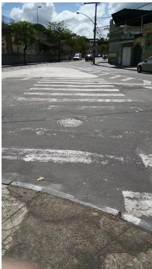
Faixa de pedestres - Apagada necessita de pintura
