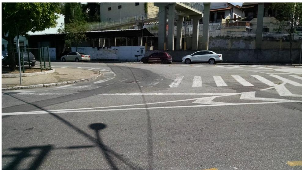
Faixa de pedestres - Apagada necessita de pintura
