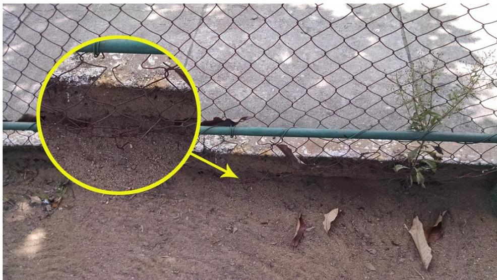
Grade do parquinho - necessita de fixação da tela na grade inferior devido às pontas de
